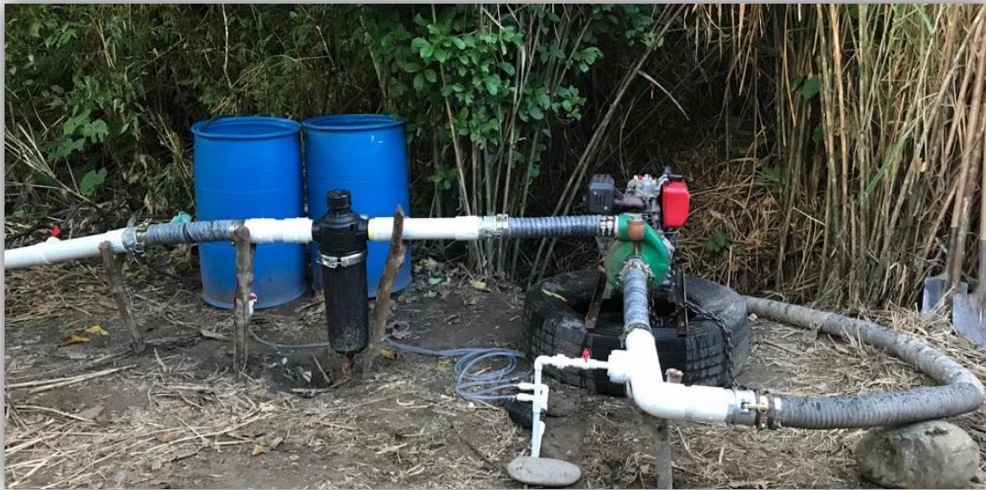
Instalación cabezal de fertirriego en cultivo de plátano
