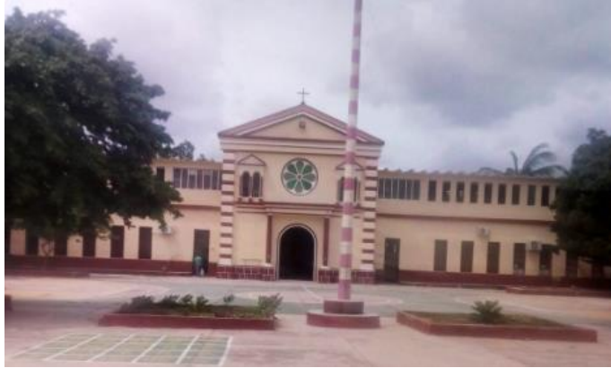
Figura 2. Instalaciones del Internado indígena San Antonio de Aremasain
