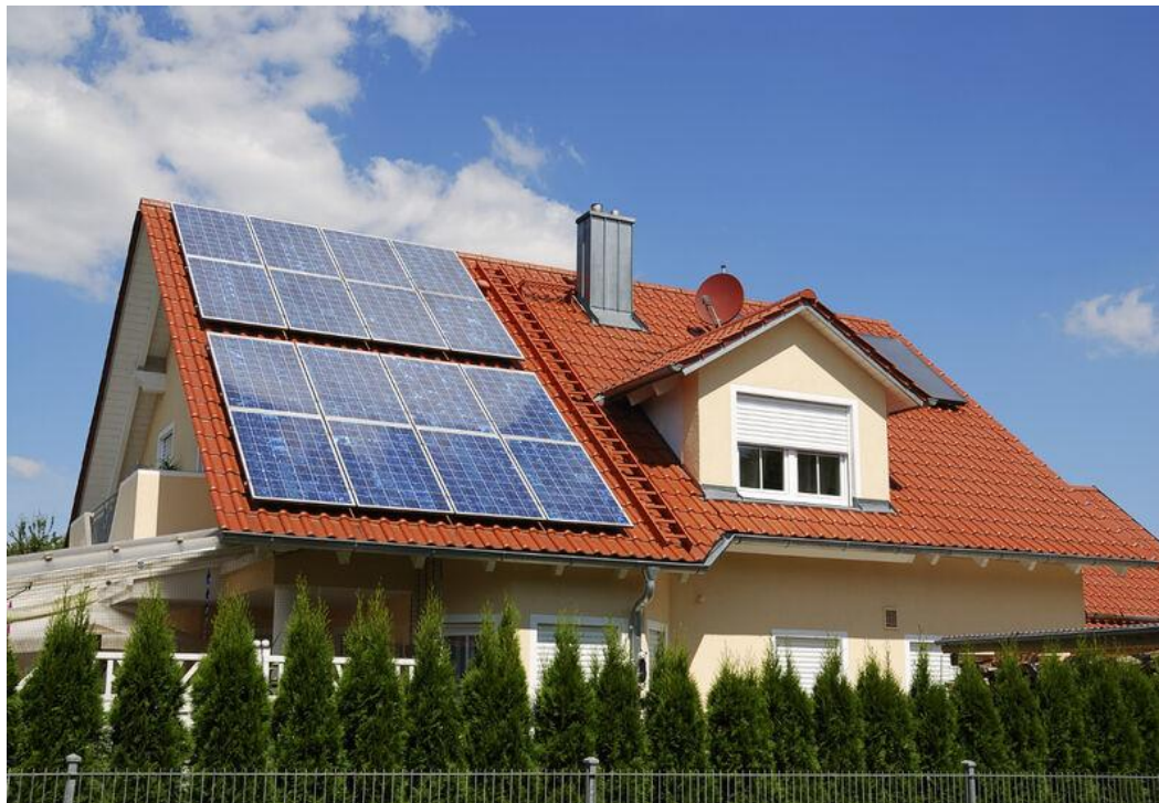
Ilustración 2.3.3-1 Vivienda con energía fotovoltaica
