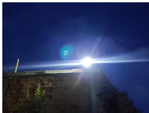
Ilustración 24: Instalación de Reflector
