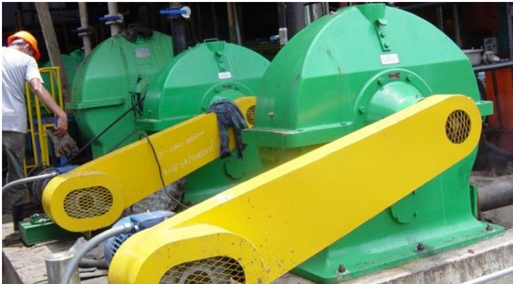
Figura 8. Centrifugas de lodos, perteneciente a clarificación. Imagen tomada de (Clarificación – GAExpertise, s. f.)
