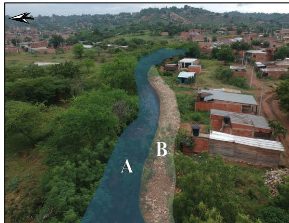
e. Cauce permanente (A) y Jarillón (B)
