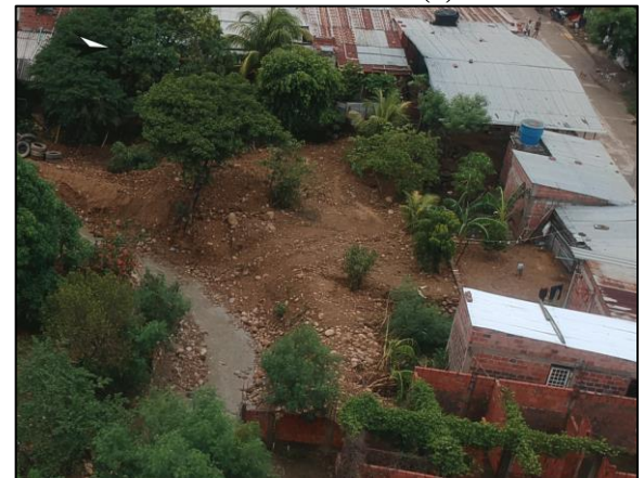
f. Zona de inundación recientemente rellenada
