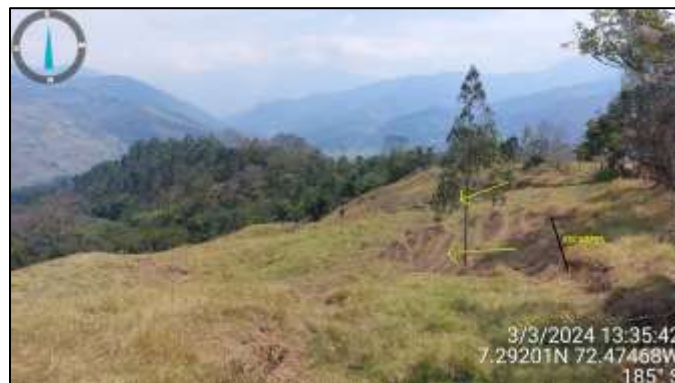
Figura 10. Zona sur-este del predio donde se observan pequeños deslizamientos.
