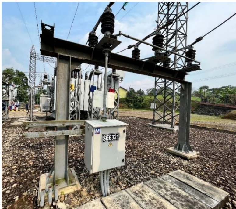
Figura 34. Seccionador 6321. Autor
