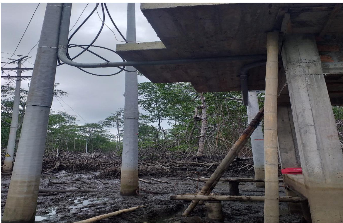
Imagen 28. Canalizaciones instaladas con los conductores de conexión al transformador.
