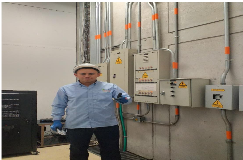
Imagen 70. Finalizando el mantenimiento
