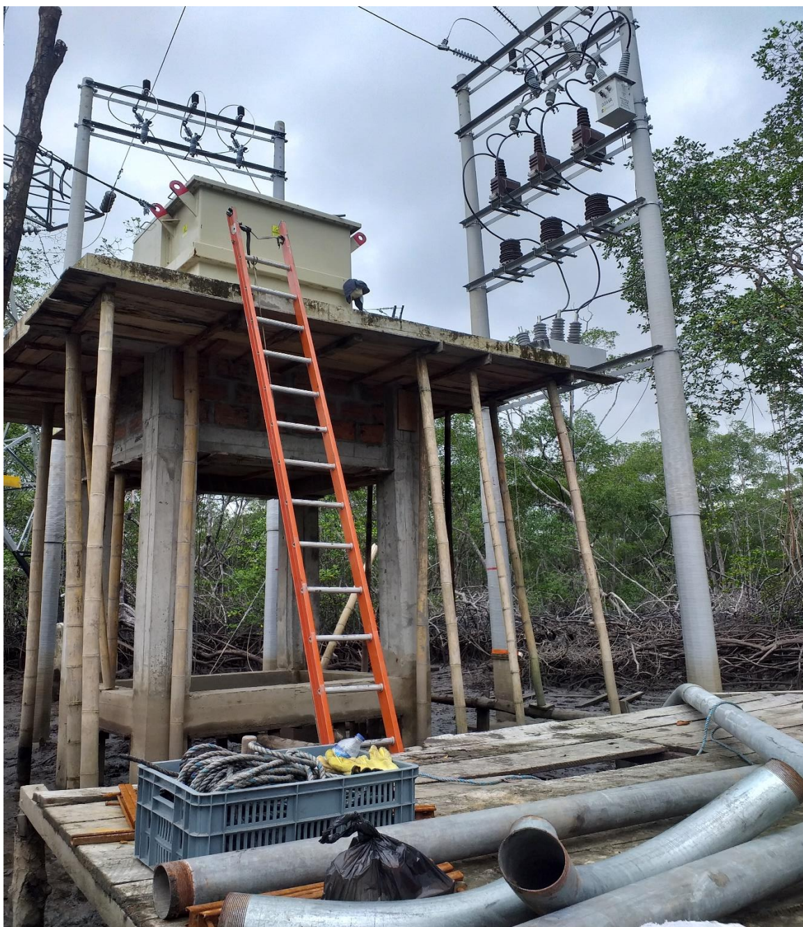
Imagen 21. Base de concreto para el soporte del transformador más estructura de equipos de las líneas de 34.5Kv para la entrada y estructura para las líneas de salida de 13.2 Kv del transformador.
