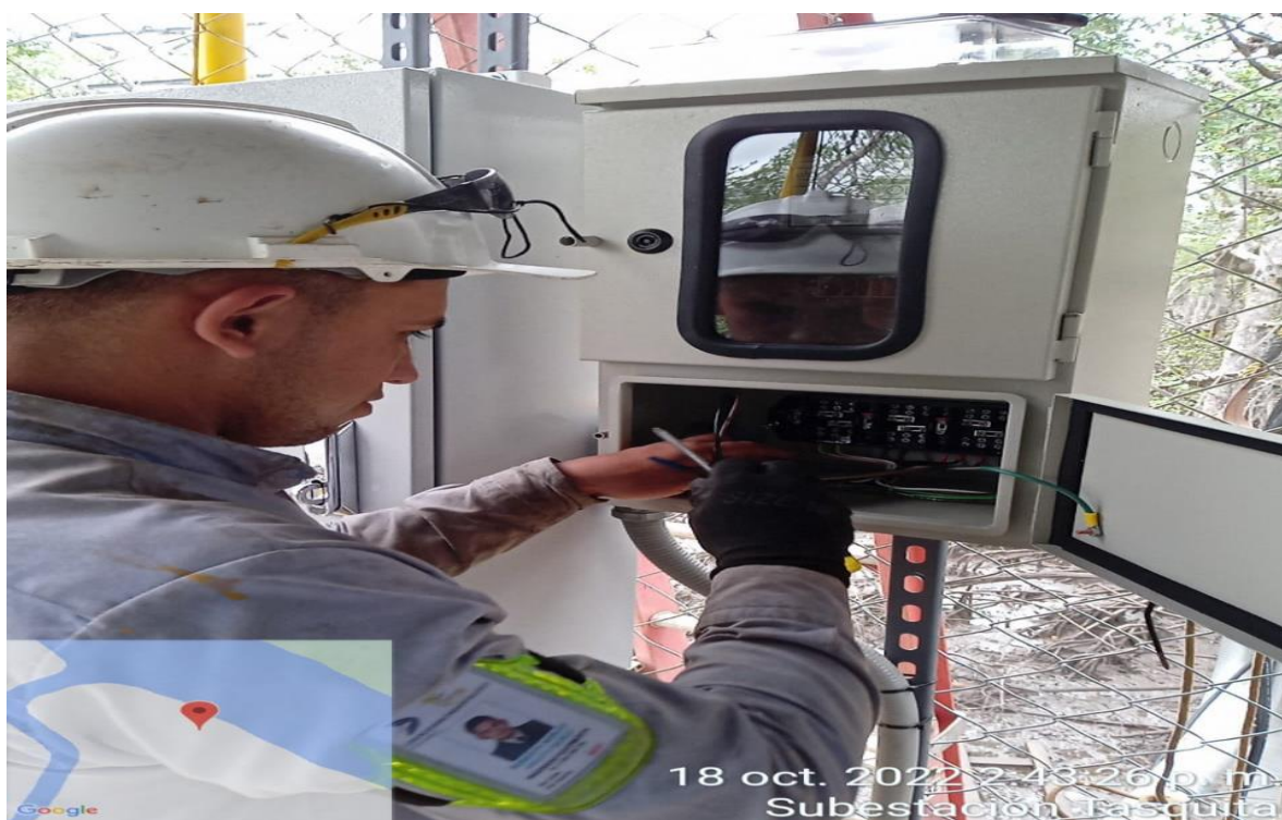
Imagen 43. Realizando la conexión del medidor principal.
