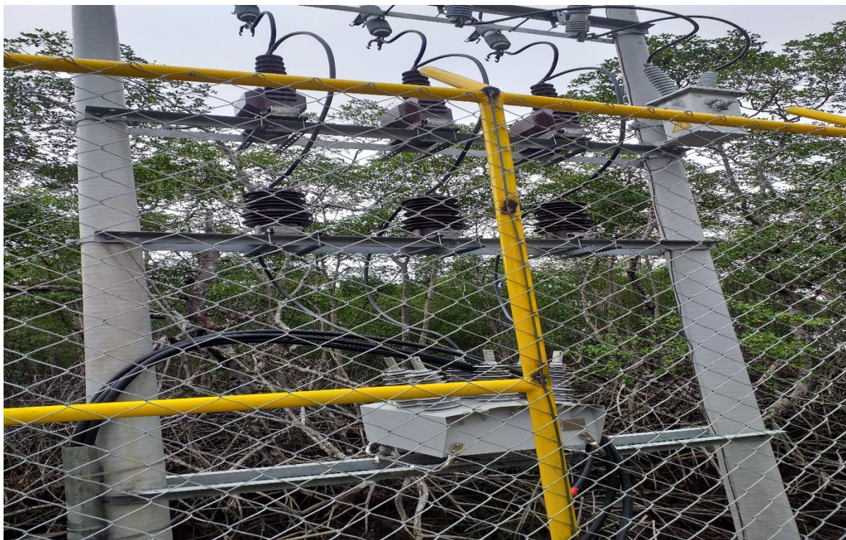
Imagen 33. Malla de encerramiento instalada
