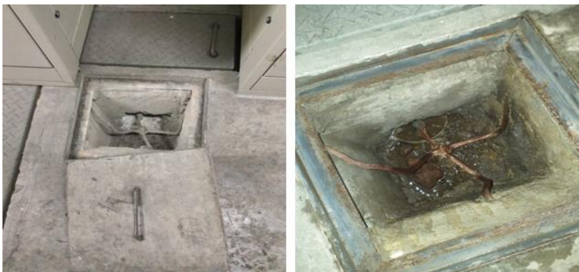
Imagen 65. Antes y después del mantenimiento al sistema puesta a tierra.
