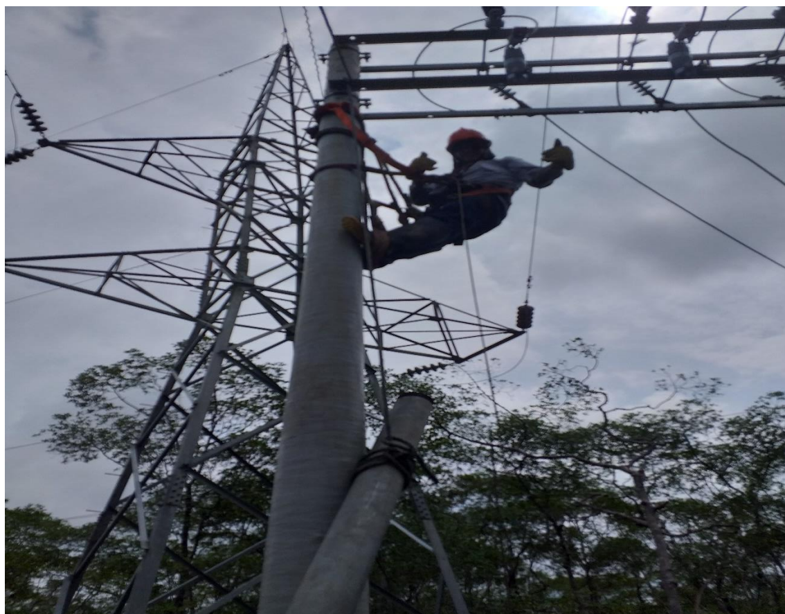
Imagen 26. Montaje de canalización en estructuras.
