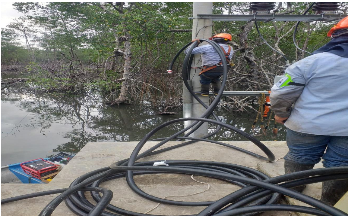
Imagen 27. Pasando los conductores por la canalización a la parte de adentro de la habitación de almacenamiento
