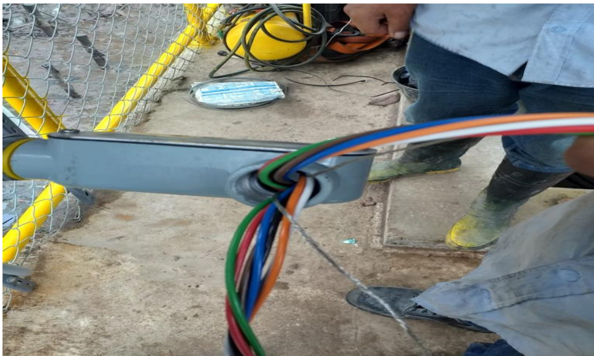
Imagen 40. Cable de control 7x12+12 descubierto y listo para realizar las conexiones
