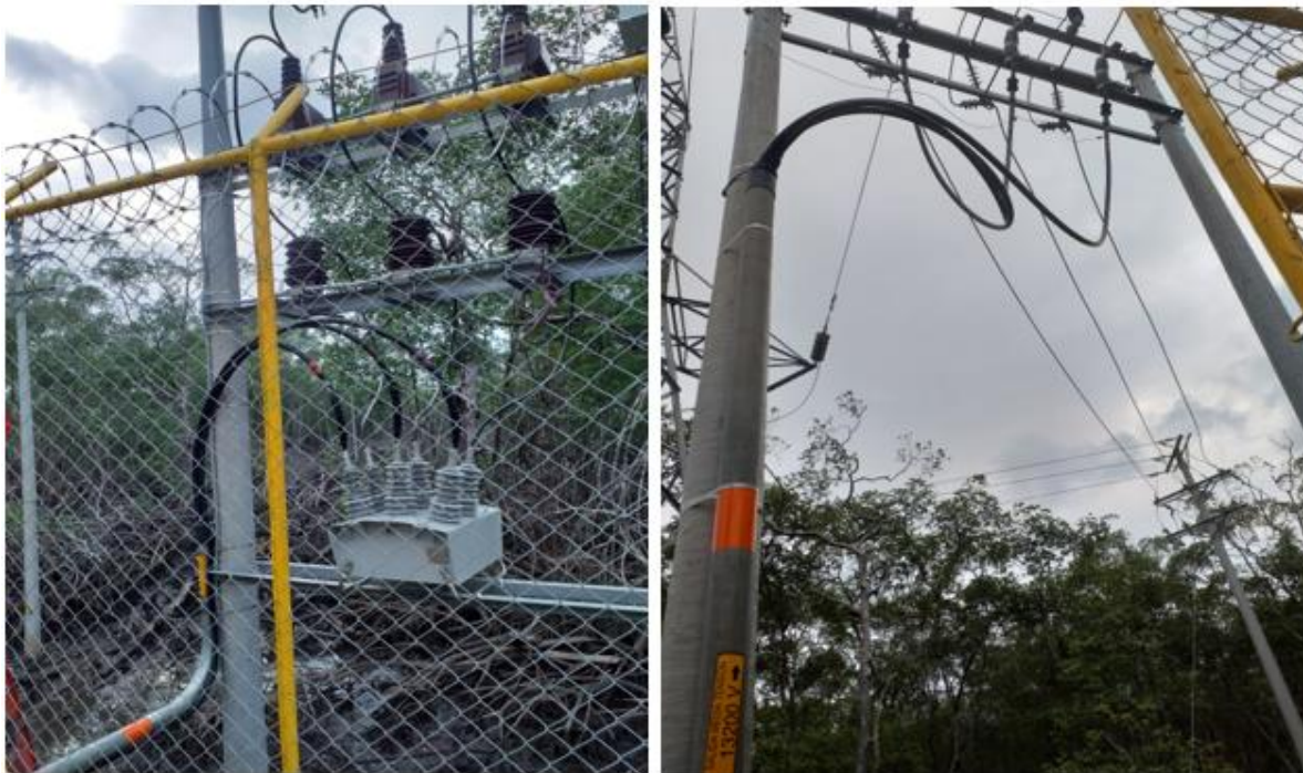
Imagen 67. Resultado de la instalación eléctrica para la entrada de 34.5Kv y la salida de 13.2Kv.
