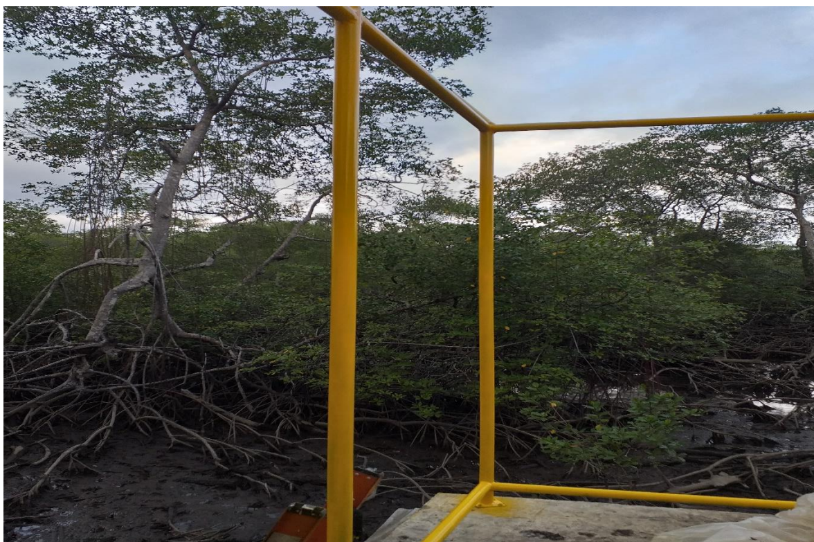
Imagen 31. Encerramiento pintado para el comienzo de la instalación de la malla
