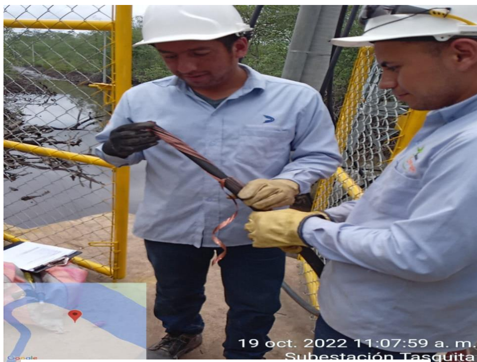
Imagen 73. Realizando los terminales premoldeados con el Ing. Nelson Rincón codirector de trabajo de grado
