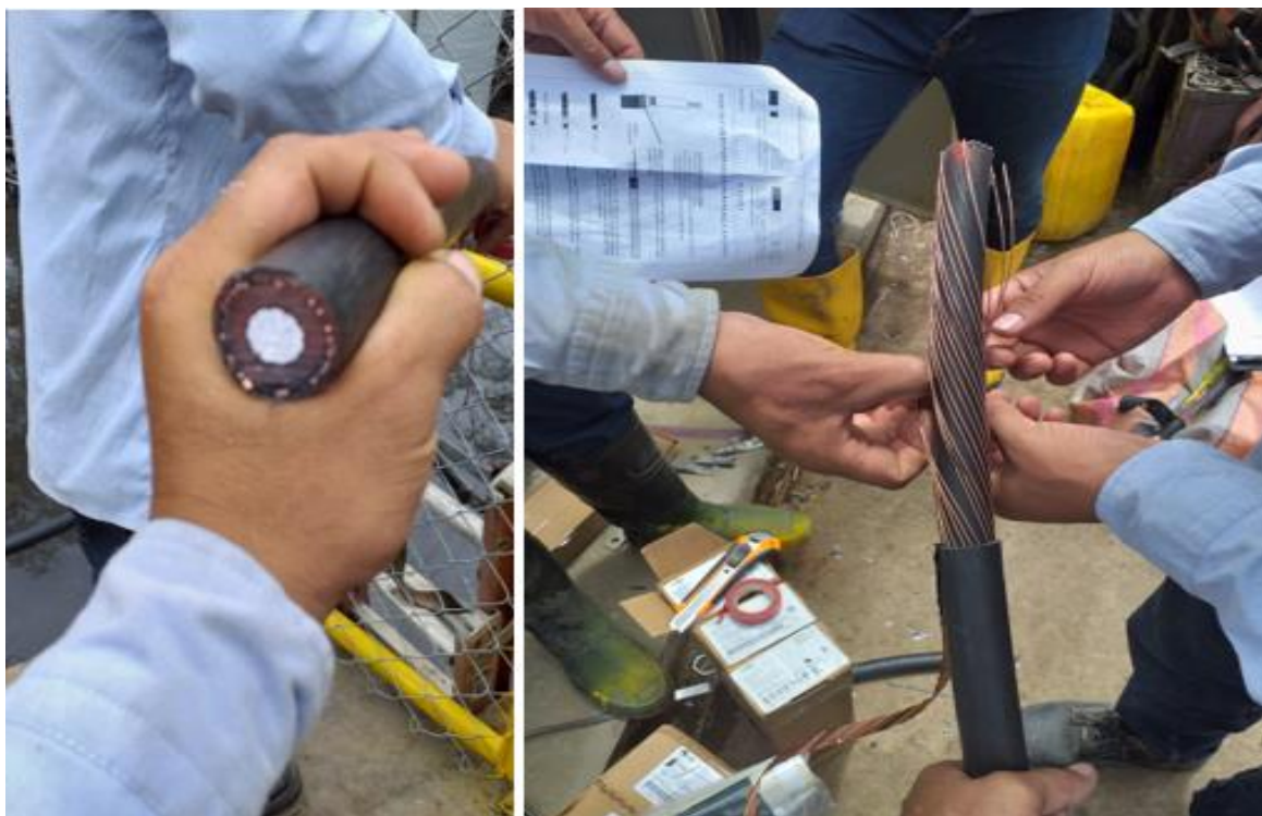
Imagen 44. Retiro de chaqueta de protección del conductor.
