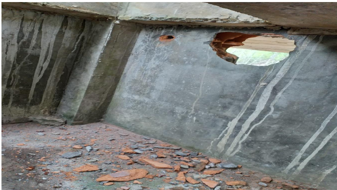
Imagen 25. Perforación para la canalización en la habitación donde se almacenan los conductores de conexión del transformador.
