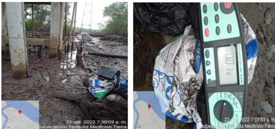
Imagen 69. Medición de resistividad del suelo mediante la malla a tierra. Telurómetro
