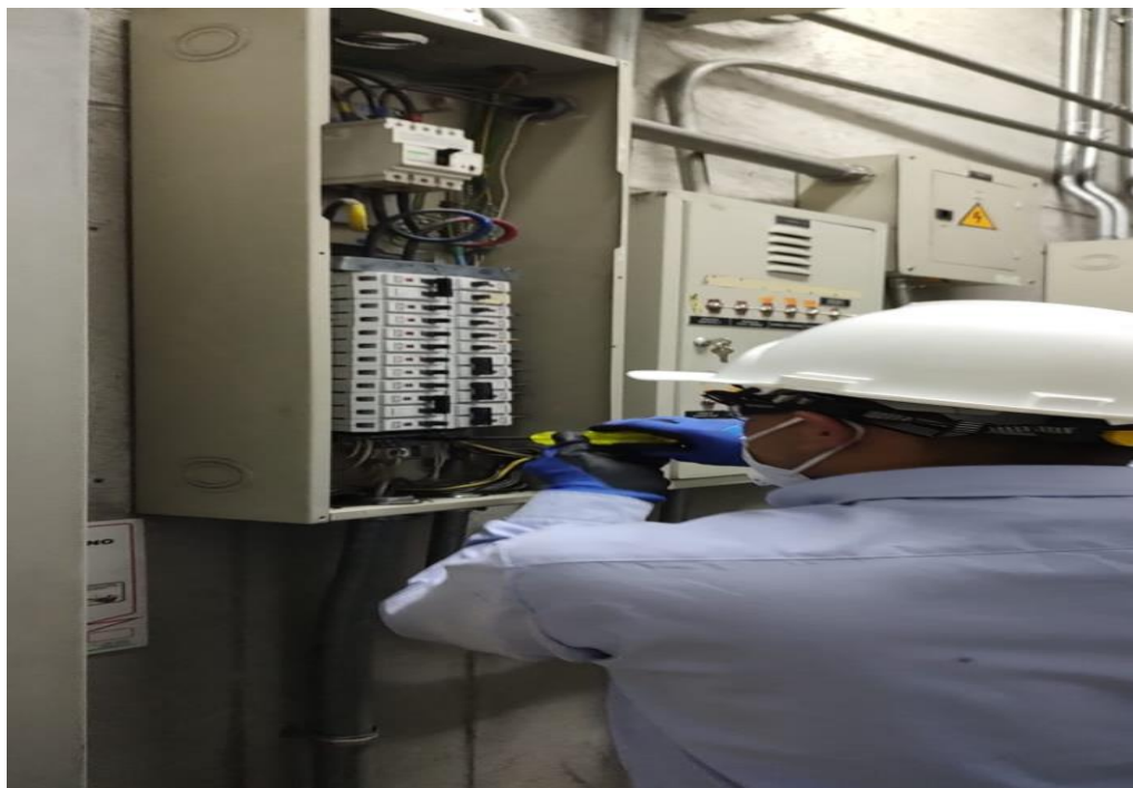
Imagen 17. Ajustando tornillería a tableros de distribución
