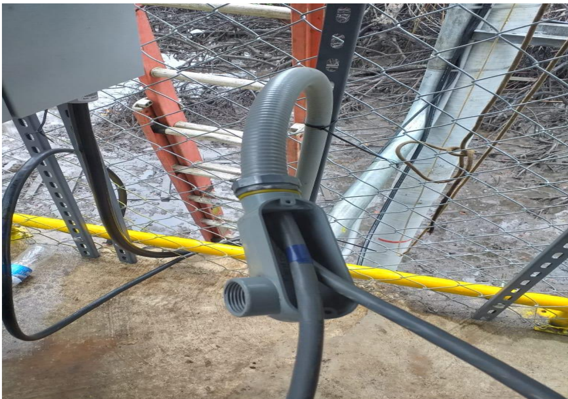
Imagen 38. Instalación de canalización y cable de control 7x12+12 de conexión para los equipos de medida
