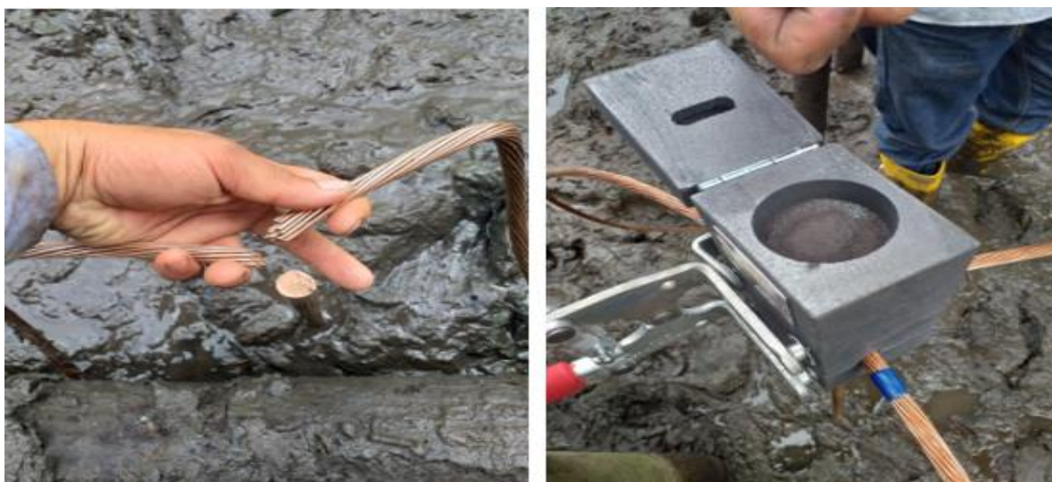
Imagen 54. Instalación de malla puesta a tierra, unión de cable de cobre con varilla de cobre de 2.4 metros.
