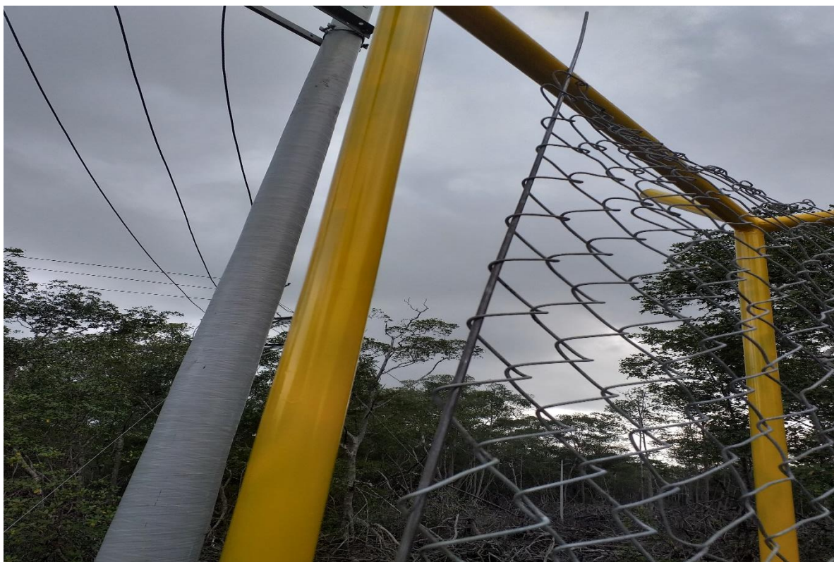
Imagen 32. Comienzo de instalación de malla
