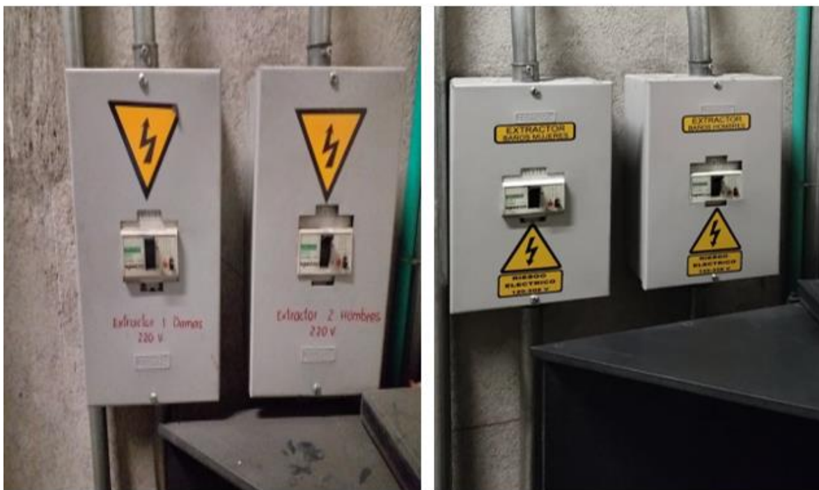
Imagen 64. Antes y después del mantenimiento realizado.
