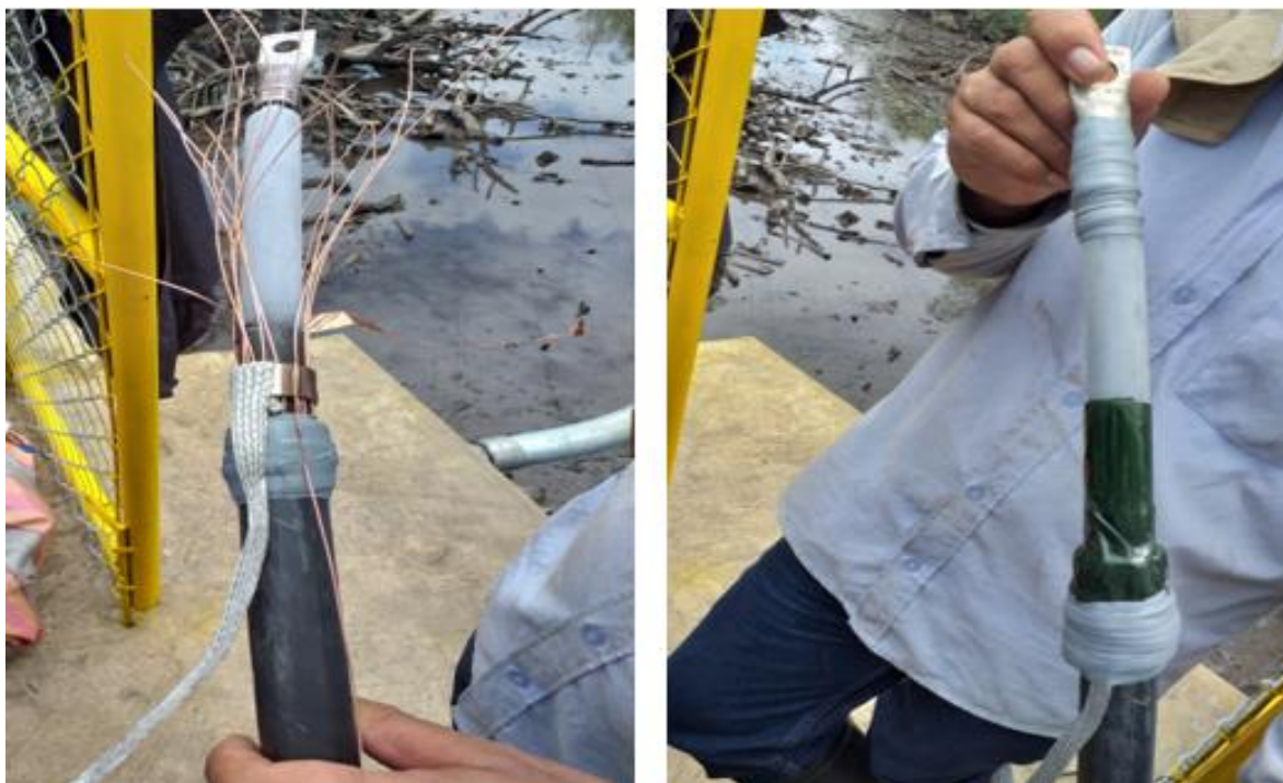
Imagen 46. Instalación del apantallamiento a tierra y cintas de aisladoras para asegurar el contacto entre los cables de cobre y la cinta a tierra.
