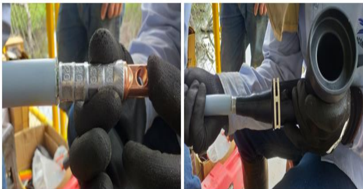
Imagen 48. Instalación del premoldeados tipo codo.
