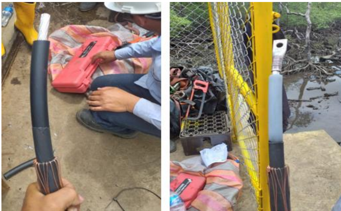
Imagen 45. Se quito con liga la capa semiconductor y se instala la terminal de ojo.
