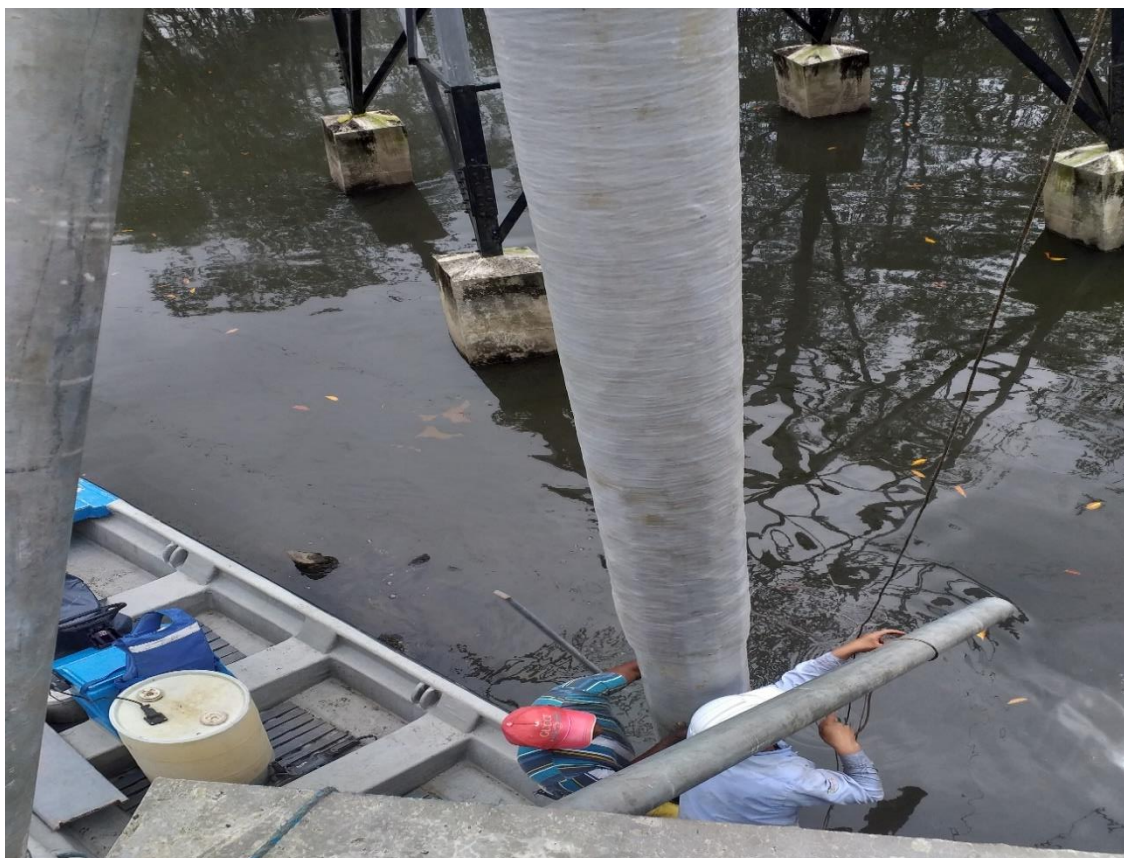
Imagen 24. Montaje de canalizaciones para conductores de conexión
