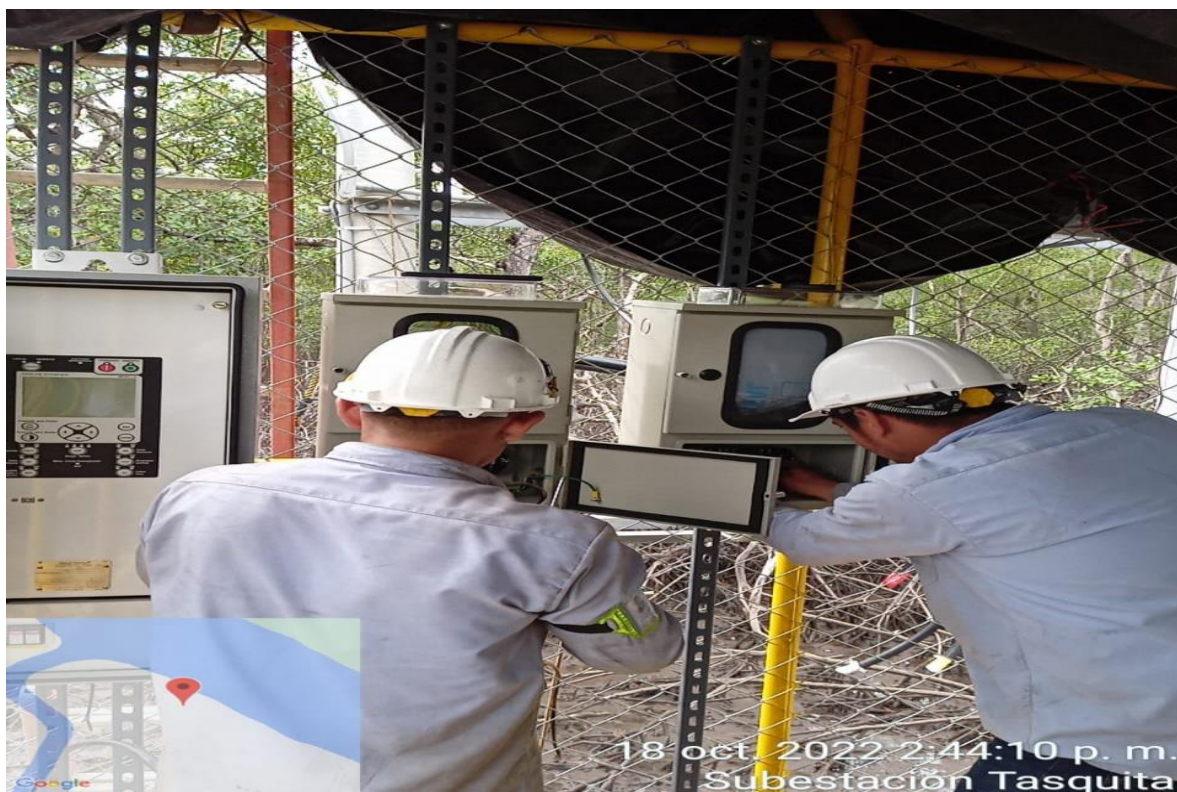
Imagen 42. Apoyo en la conexión de los medidores
