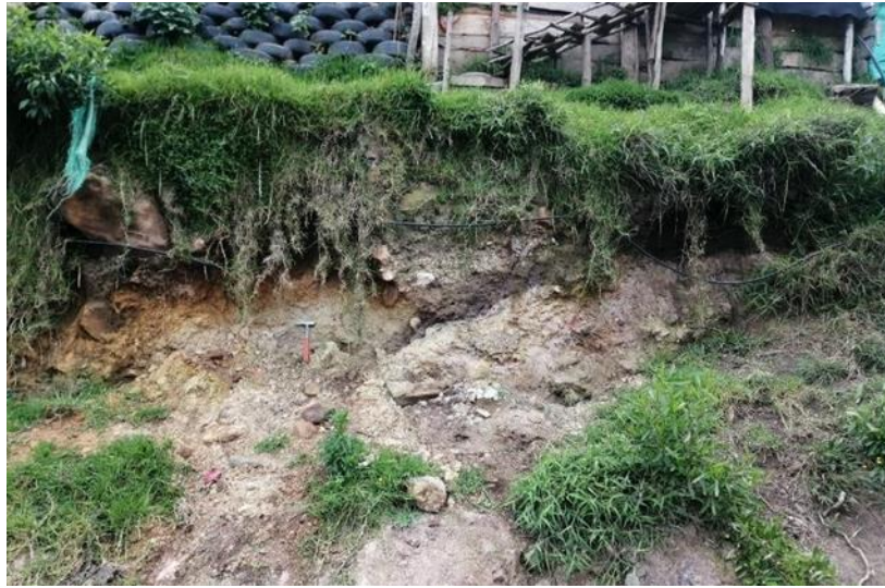
Fotografía 6 Afloramiento de suelo residual arcillo-arenoso de la estación 7. Fuente: Autor, 2022
