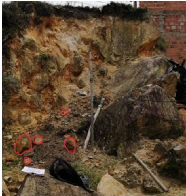
Fotografía 7 Movimiento en masa compuesto, deslizamiento traslacional de arcillolitas y arenisca con caída de rocas con una orientación N82°W. Fuente: Autor, 2022
