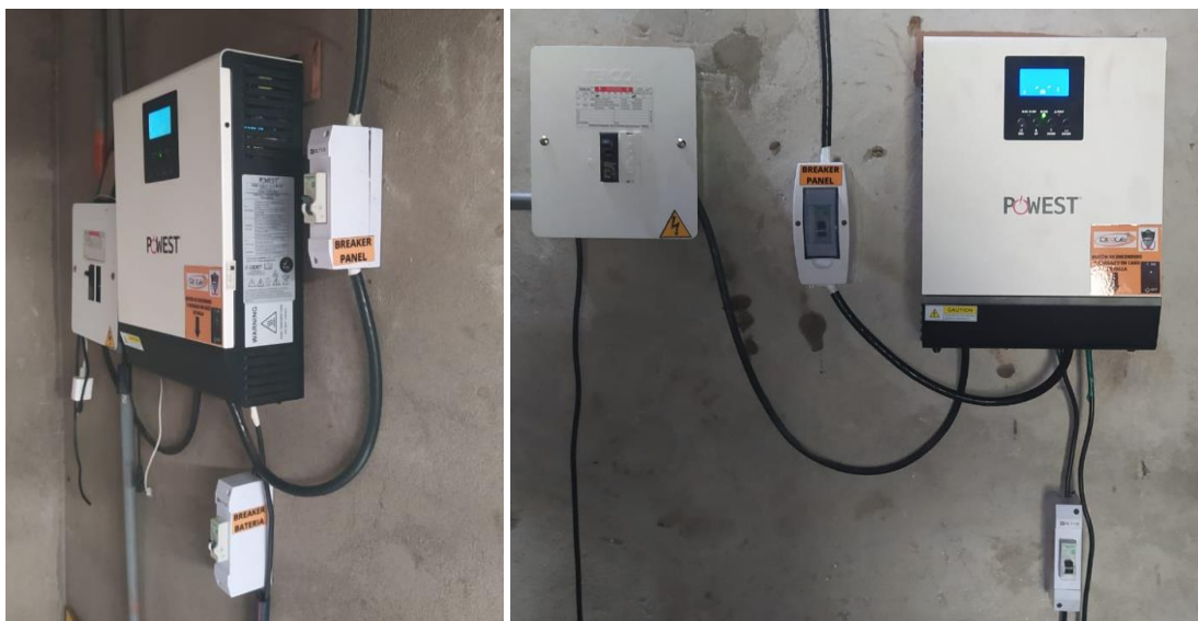
Figura 35. Inversor instalado
