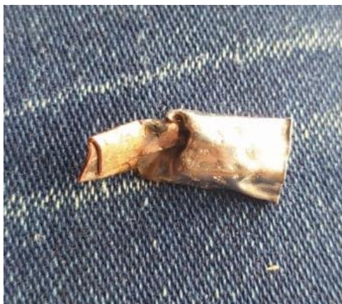
Figura 40. Terminal quemado por donde se provocó la avería del inversor
