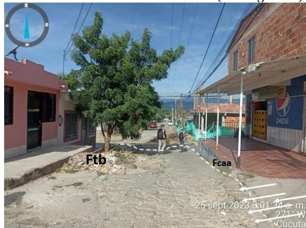
Figura 22. Elemento morfodinámica de flujo de detritos en el asentamiento 13 de Mayo. Fuente: Autor(es).
