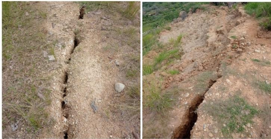
Figura 10. Grietas fotografiadas en campo
