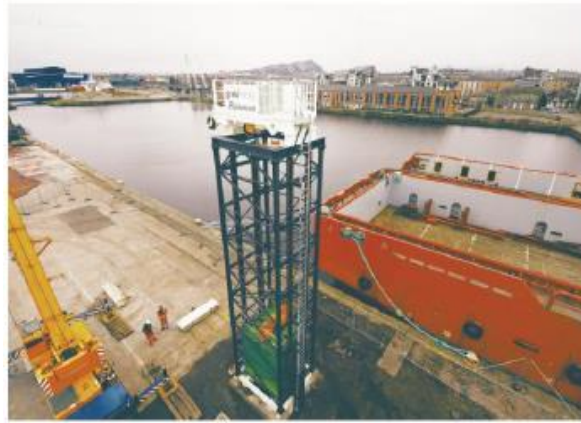
Ilustración 4: Almacenamiento de energía por gravedad en torre de la empresa Gravitricity.
