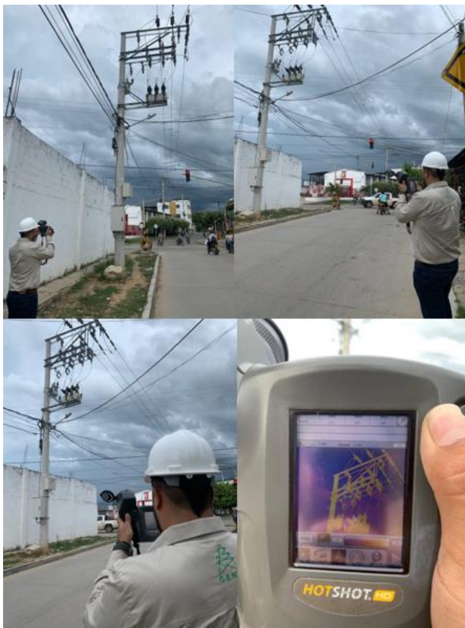
Figura 2. Medición termográfica con cámara HOTSHOT HD-XT.
