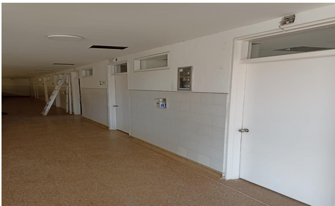
Ilustración 44. Evidencia de trabajo zona UCI y cuarto de recuperación
