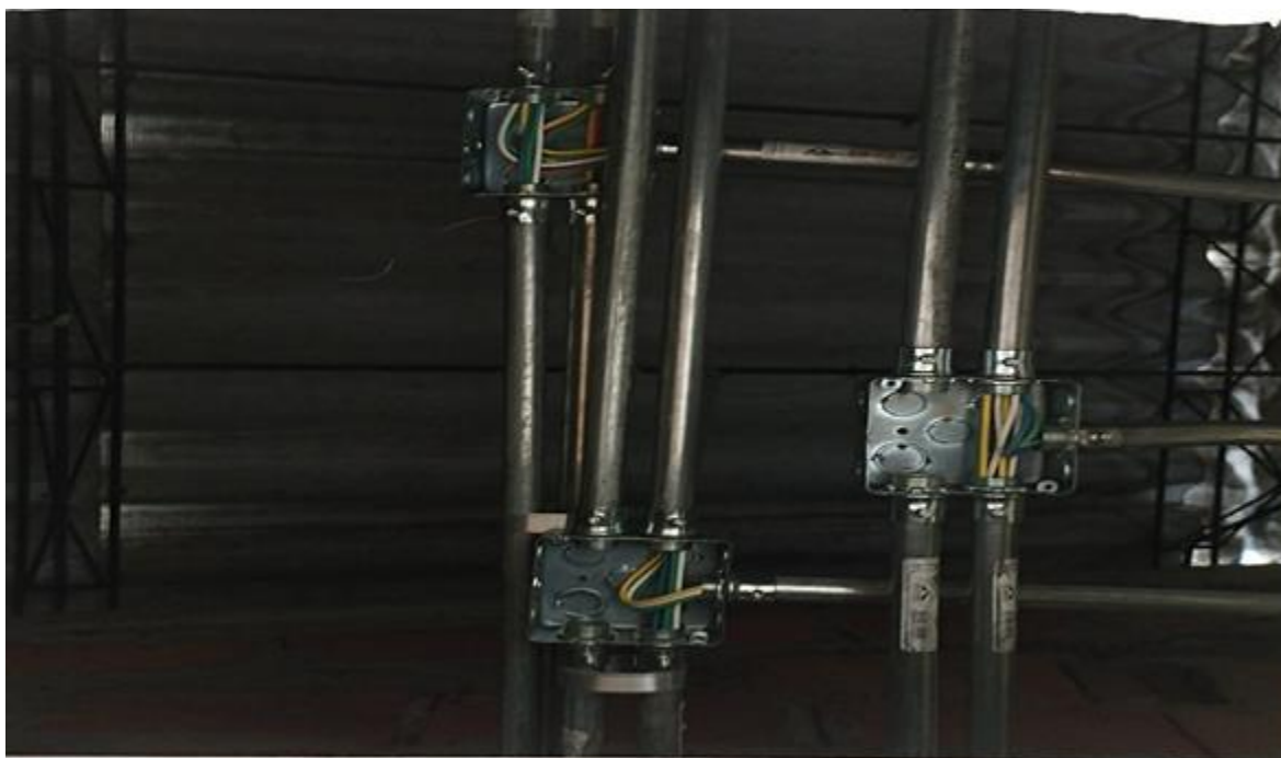
Ilustración 46. Ejecución de tubería aérea y alambrado
