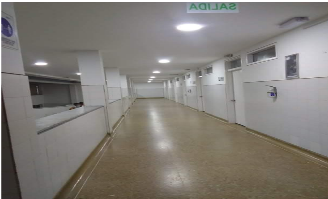
Ilustración 48. Evidencia de iluminación, zona UCI
