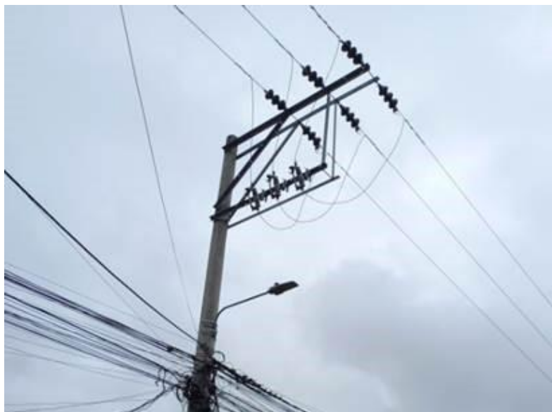
Figura 3 Cortacircuitos.[1]
