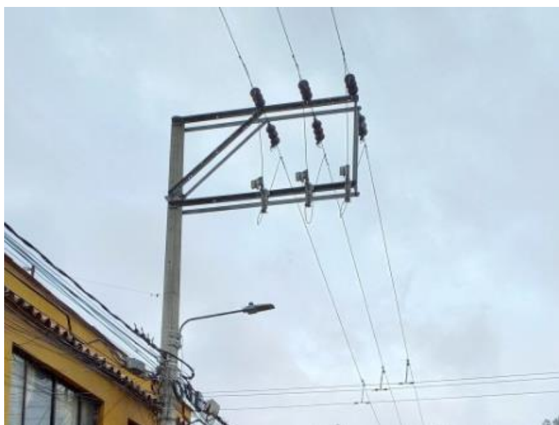
Figura 4 Cortacircuitos ahoga arco o bajo carga.[1]
