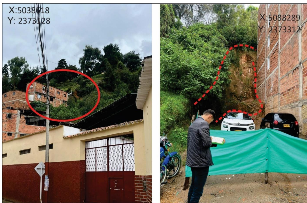
Figura 27. erosión antrópica y pluvial.
