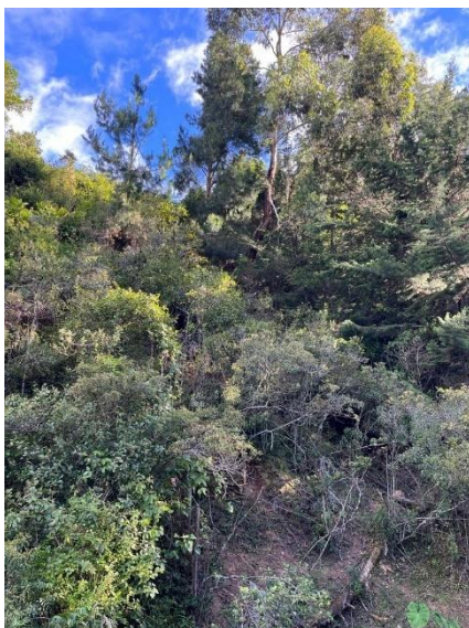
Figura 15. Reptación del terreno.
