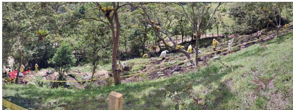
Figura 14. Fotografía de línea 1 con vista hacia el W.
