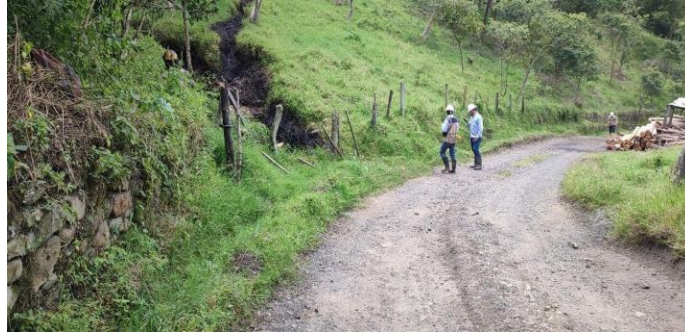
Figura 32. Fotografía de línea 7 con vista hacia el E.
