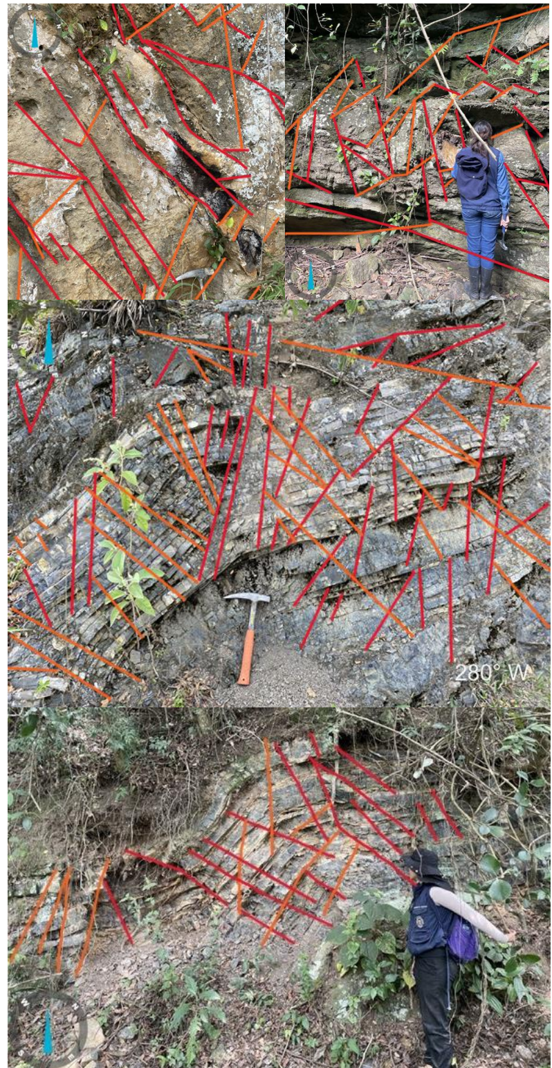
Figura 26. Patrones de fractura en afloramientos representativos de la zona de estudio de la Falla de Gramalote. Fuente: Autor(es).
