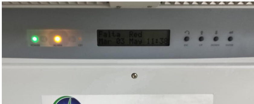
Ilustración 34 Verificación del sistema fotovoltaico
