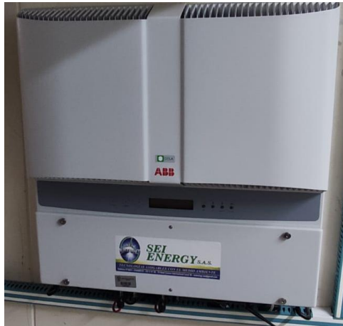
Ilustración 21 Inversor de red de C.C / C.A
