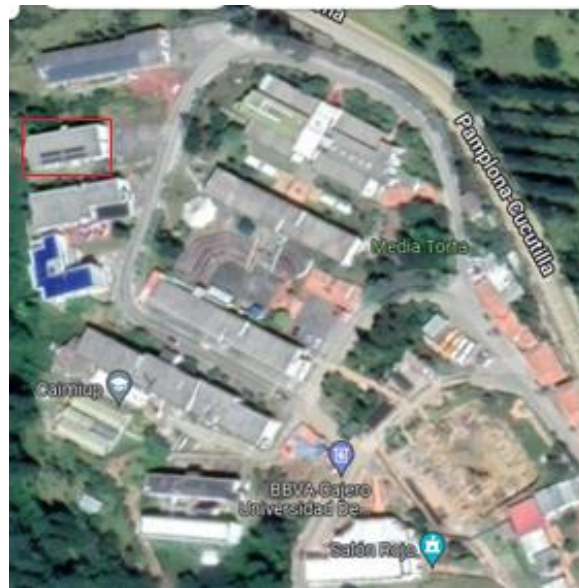
Ilustración 17 Ubicación del sistema fotovoltaico conectado a la red
