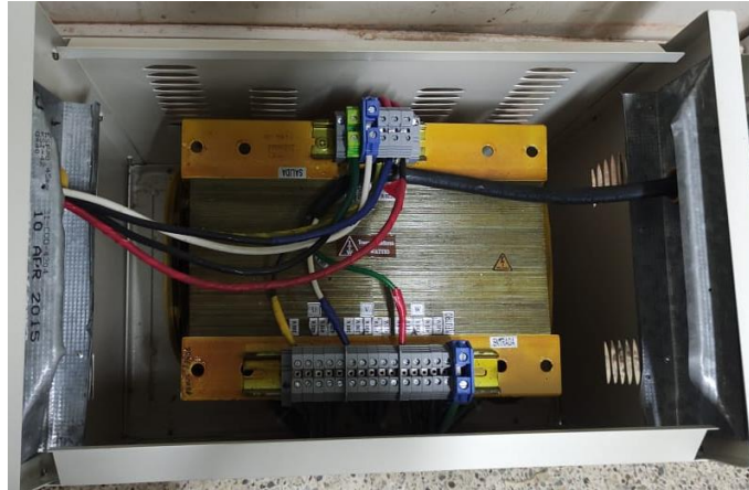
Ilustración 23 Transformador
