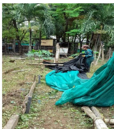
Ilustración 5 Adecuación de la zona para siembra
