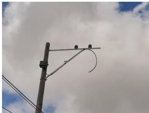
Ilustración 27. Estructura instalada tipo bandera.
