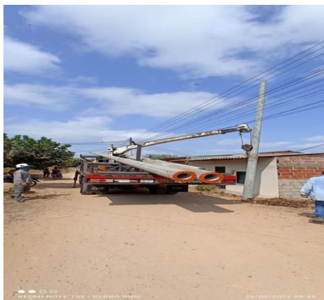
Ilustración 20. Hincado de postes en el terreno.
