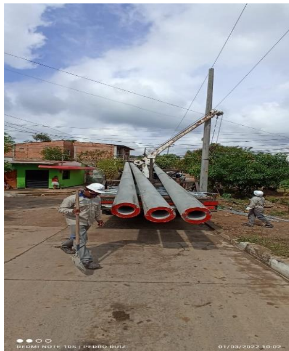
Anexo 4. Hincado de poste.
