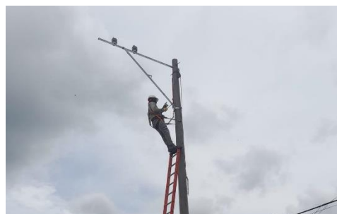
Ilustración 23. Operario instalando estructura en configuración bandera.
