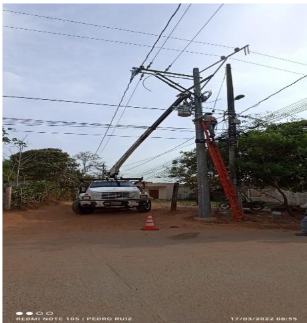
Anexo 15. Instalación de transformador.
