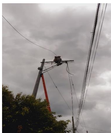
Ilustración 25. Instalación de la retenida en configuración especial.
