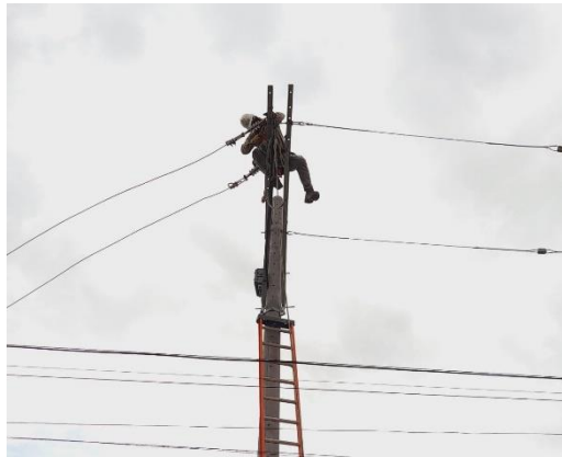
Ilustración 28. Operario instalando conductores de media tensión.
