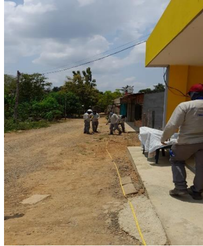
Ilustración 14. Operarios realizando inspección del terreno.
