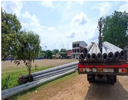
Ilustración 3. Carga de postes.
