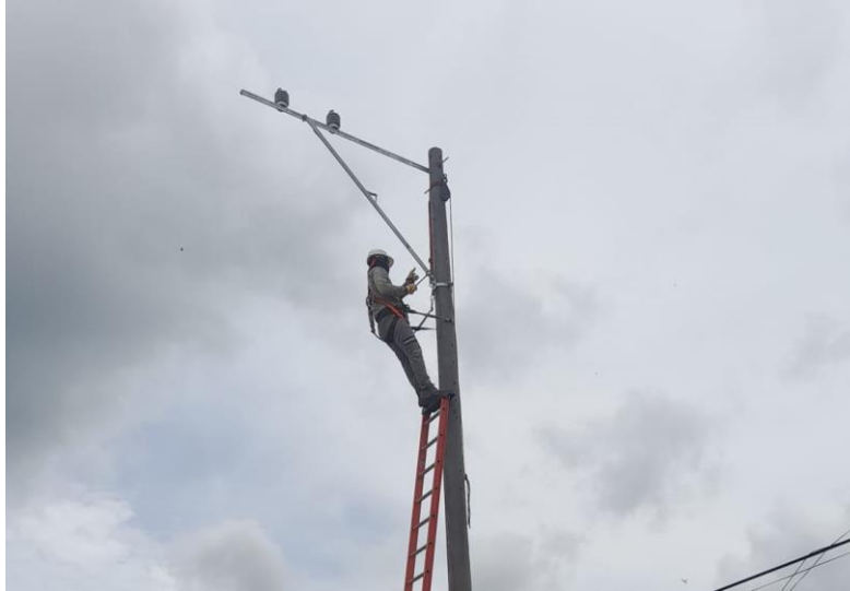
Anexo 7. Instalación de armado.
