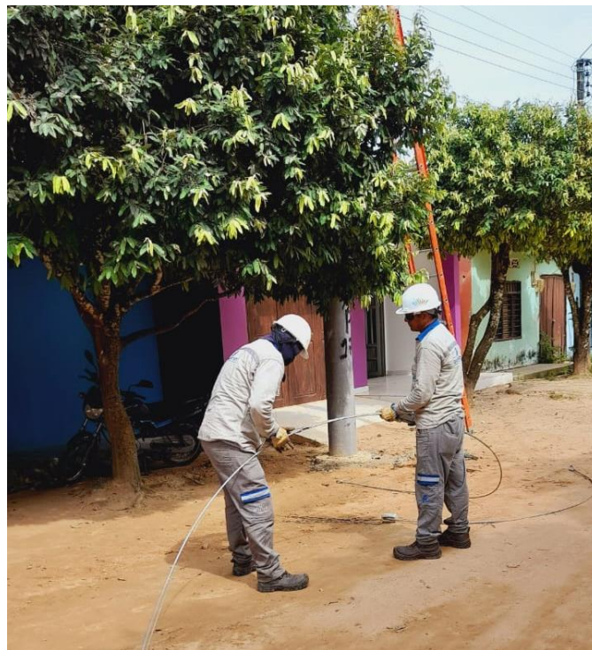
Anexo 8. Armado de retenida.
