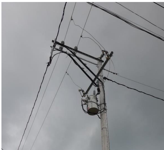
Ilustración 33. Transformador instalado.
