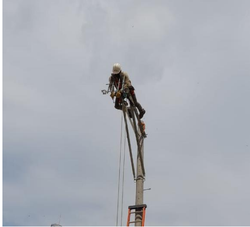
Ilustración 30. Operario instalando armado para baja tensión.
