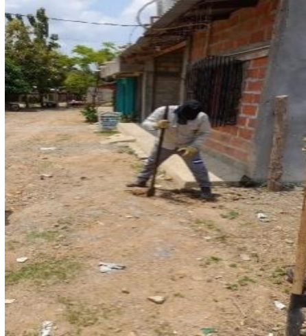
Ilustración 19. Operario realizando excavaciones.
