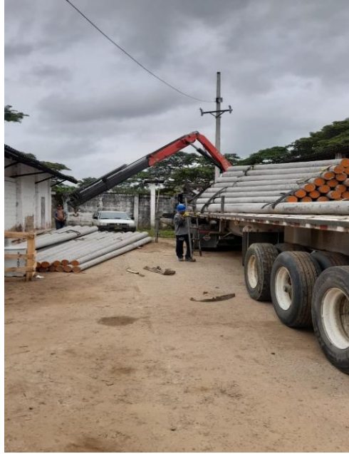
Anexo 3. Descargue de postes.
