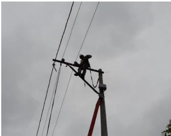
Ilustración 31. Operarios realizando instalación de conductores en BT.
