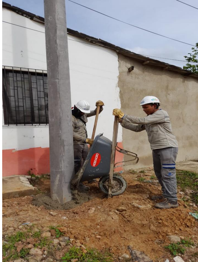
Anexo 5. Cimentación de poste.
