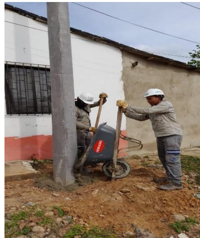
Ilustración 21. Cimentación de postes realizada por un operario.
