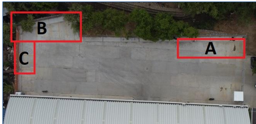
Ilustración 8. Vista de la zona de parqueo
