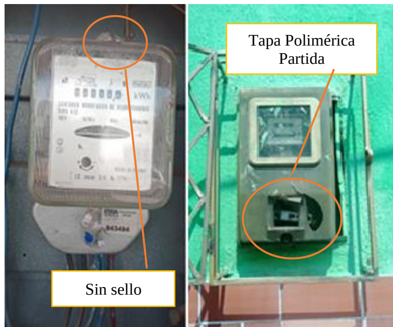
FIGURA 36 Medidores con manipulación
