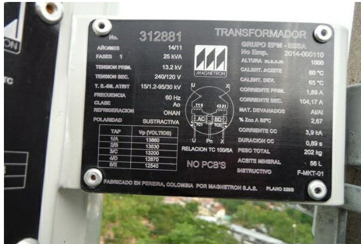
FIGURA 46 Placa característica transformador monofásico
