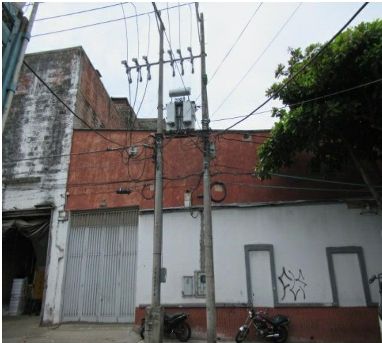
FIGURA 33 Transformador circuito 1106.
