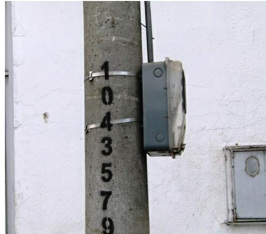
FIGURA 34 Apoyo ubicación transformador 1106.
