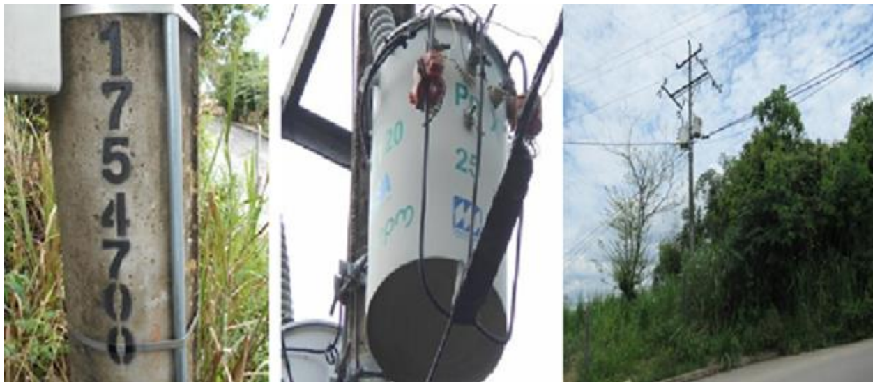
FIGURA 39 Inspección del transformador
