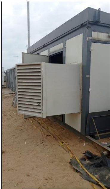
Ilustración 54 Adecuación ventilación
