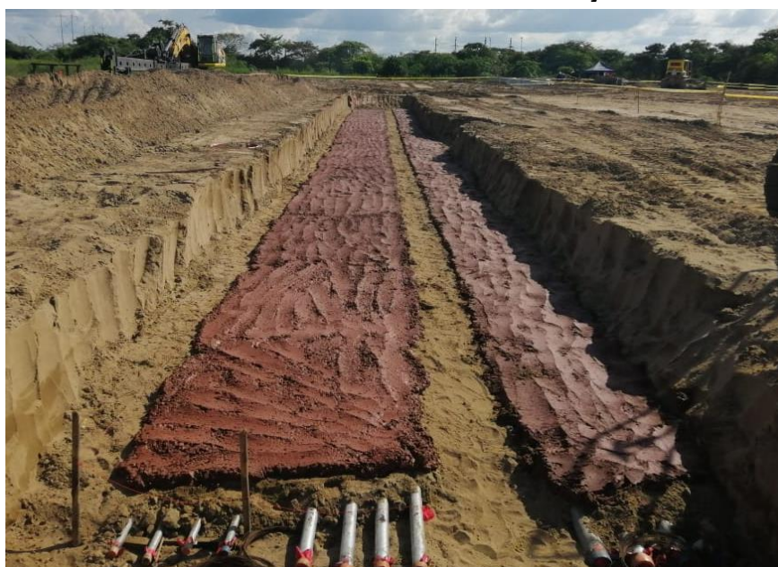
Ilustración 42 Relleno de mineral rojo
