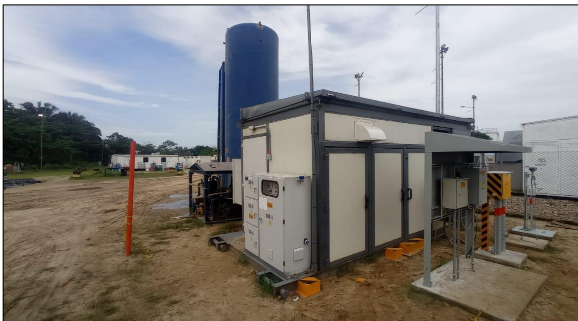
Ilustración 64 Subestación finalizada
