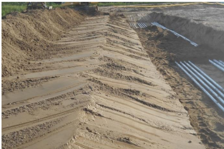
Ilustración 41 Tendido de tubería
