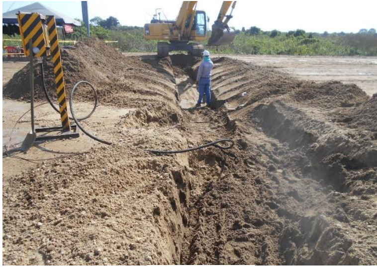
Ilustración 43 Tendido cable 5KV
