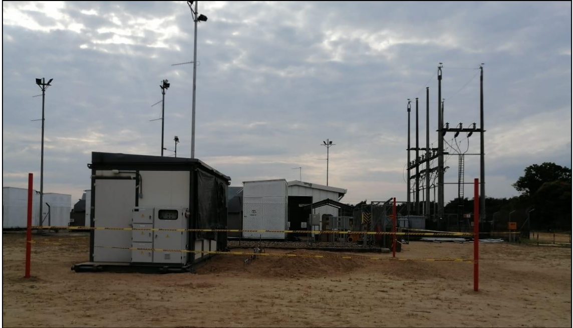
Ilustración 45 Instalación del skid
