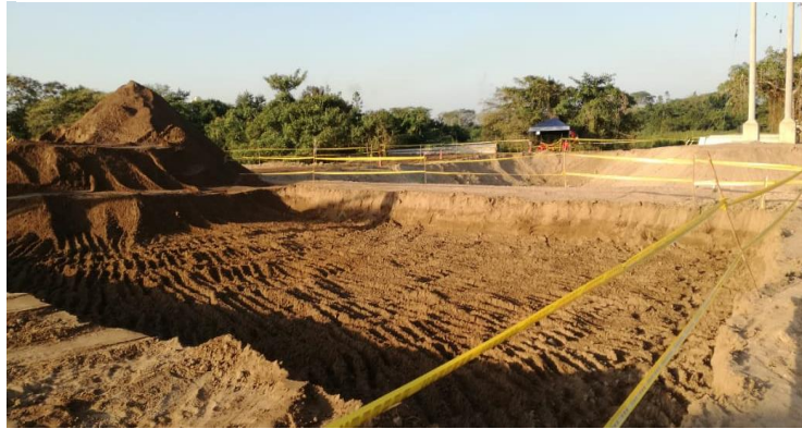
Ilustración 37 Inicio construcción malla a tierra
