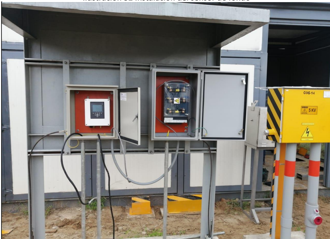
Ilustración 52 Instalación del sensor de fondo
