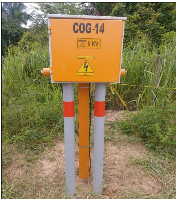
Ilustración 50 Instalación caja de venteo
