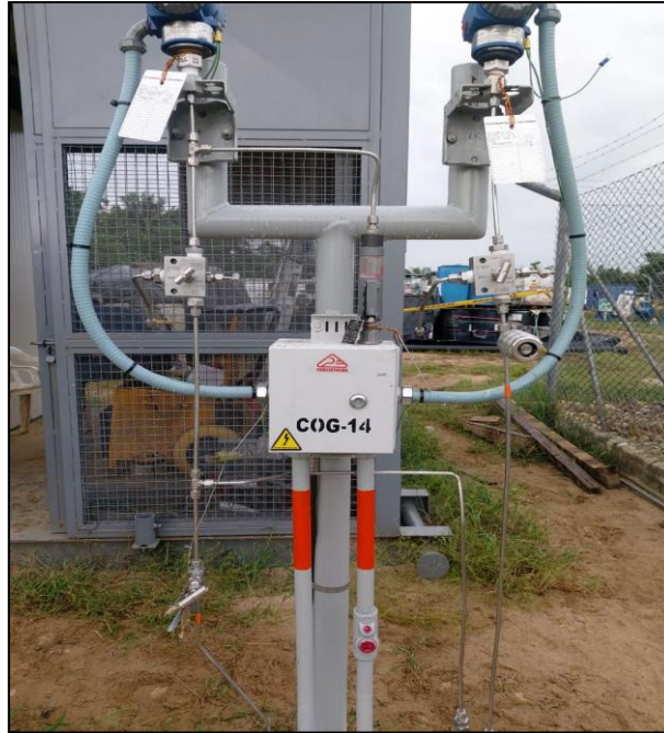
Ilustración 51 Instalación del PIT
