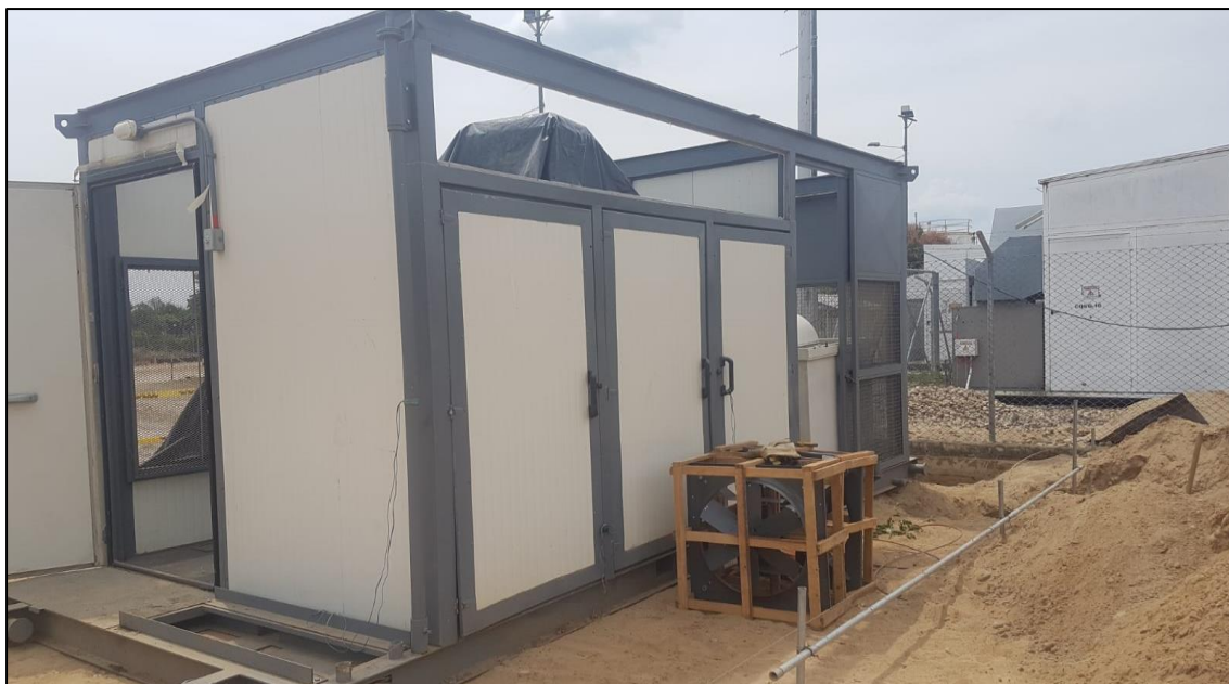
Ilustración 63 Subestación antes de la construcción
