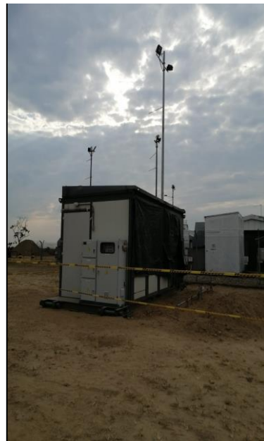
Ilustración 53 Adecuación de iluminarias
