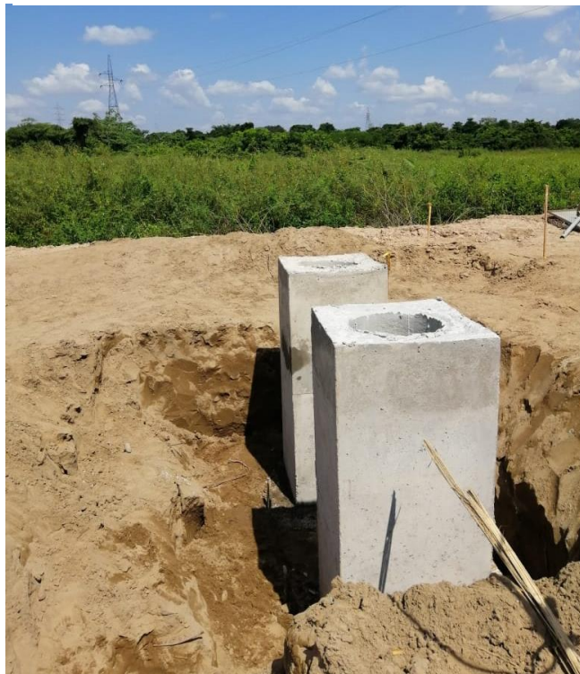
Ilustración 40 Hincado de postes para el pórtico
