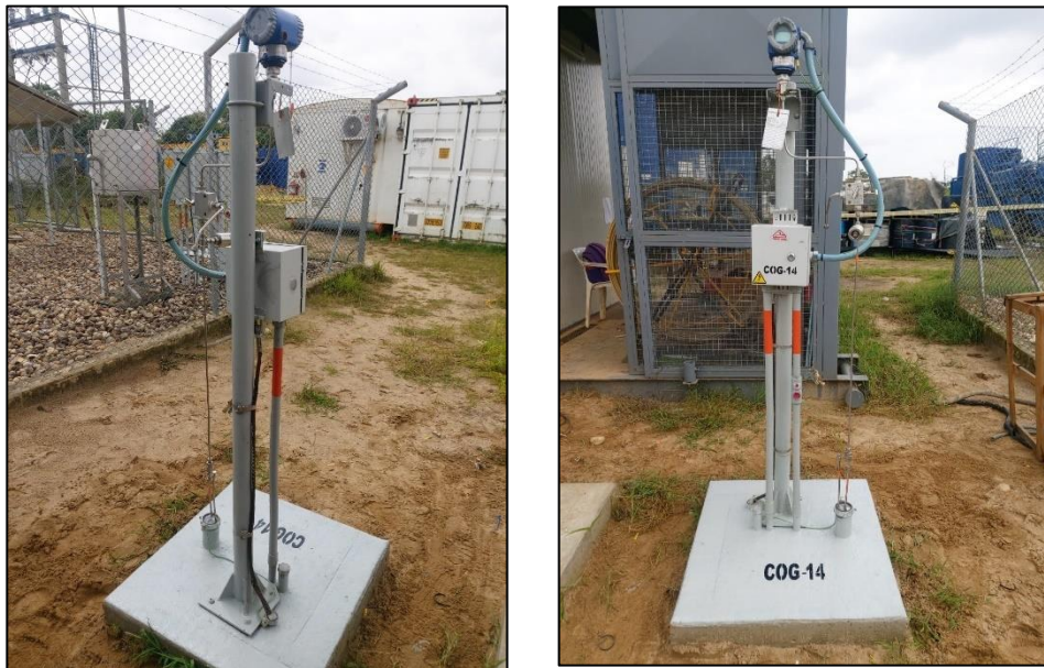
Ilustración 57 Adecuación del PIT
