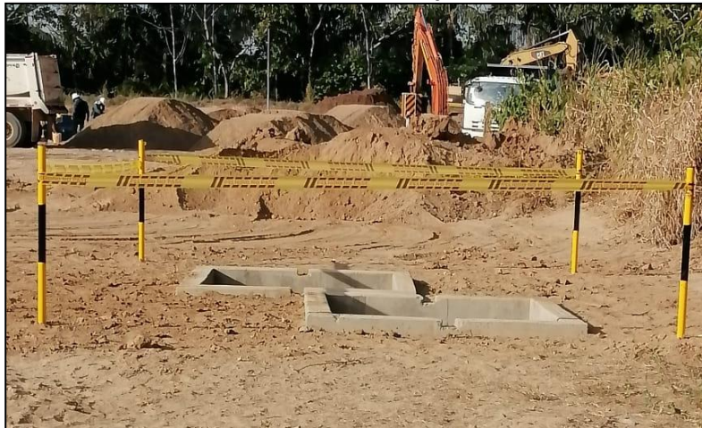
Ilustración 44 Instalación de caja de halado
