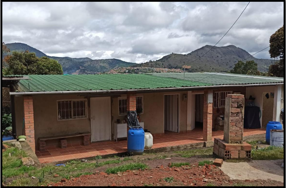
Figura 29 Lugar de la instalación fotovoltaica
