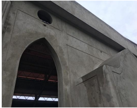
Figura 8. Templo en construcción del Diamante.
