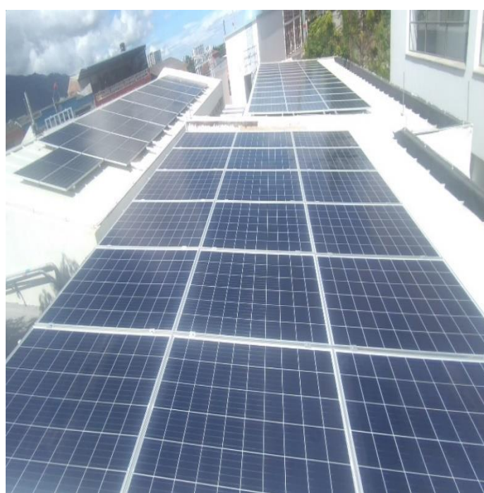
Ilustración 58 Envergadura de los paneles en las cubiertas intervenidas.
