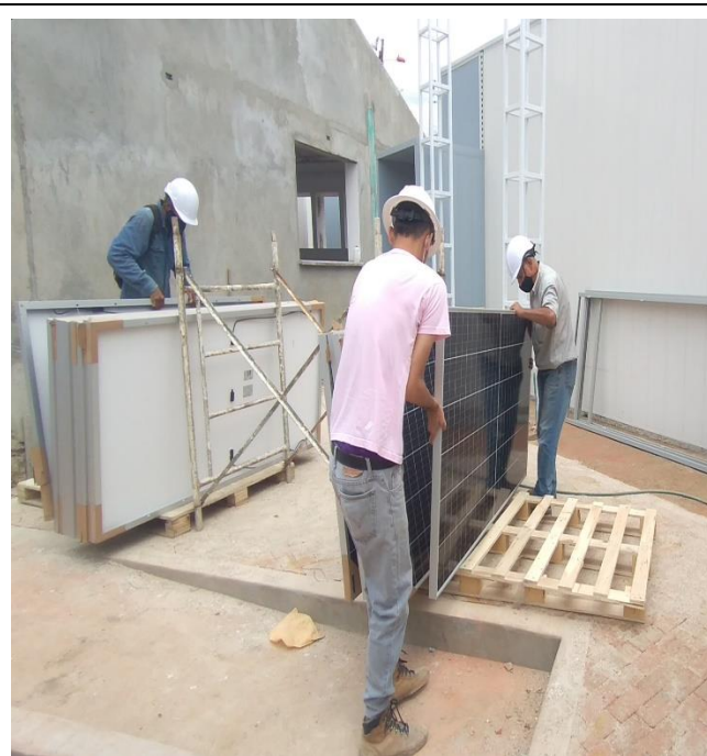
Ilustración 50 Labores en obra como ingeniero practicante
