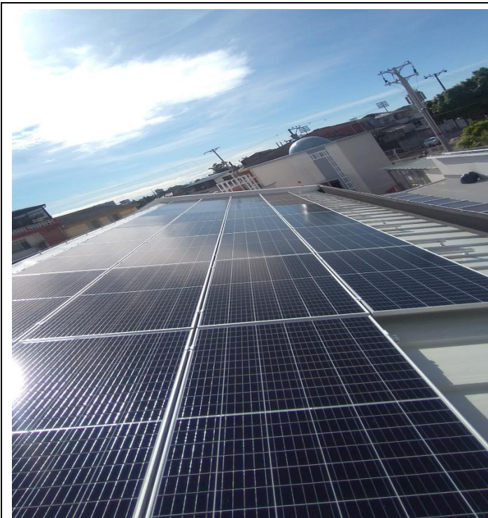
Ilustración 53 Cubierta A con los paneles fijados a la estructura.
