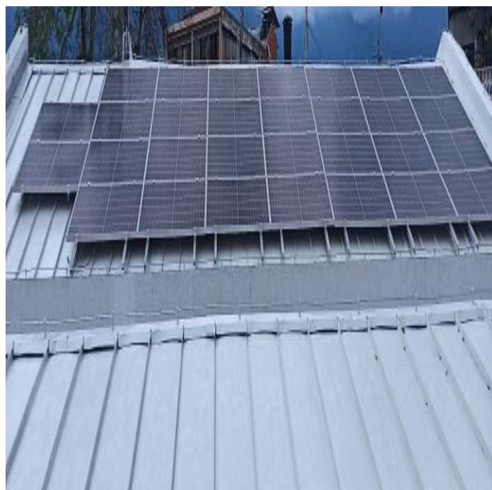
Ilustración 54 Montaje en la cubierta A
