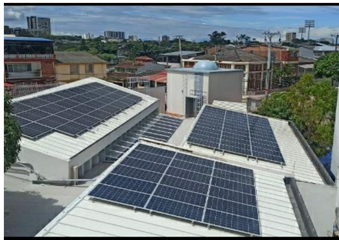
Ilustración 18 cubiertas intervenidas, donde se instalaron los paneles del sistema fotovoltaico.
