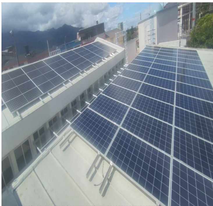
Ilustración 57 Envergadura de los paneles en las cubiertas intervenidas.
