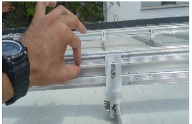
Ilustración 13 Nivelando la estructura para fijarla y que los paneles queden bien distribuidos.
