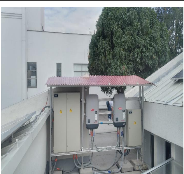
Ilustración 26 Gabinetes e inversores instalados y operando.
