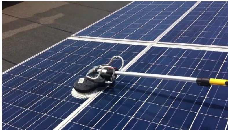
Ilustración 37 Técnica de limpieza de paneles con cepillo removedor
