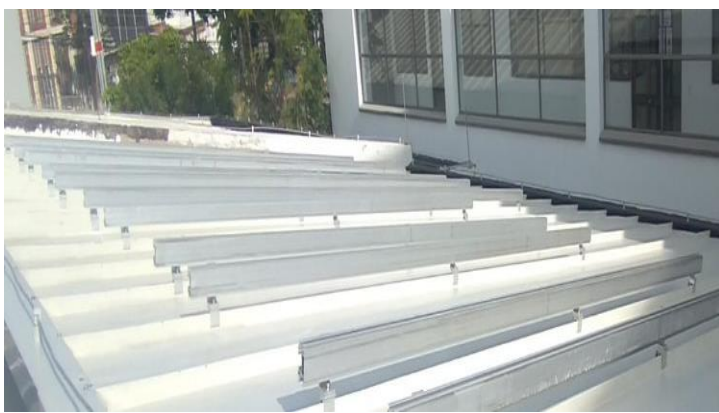
Ilustración 14 Estructura en aluminio, que fija los paneles a la cubierta.
