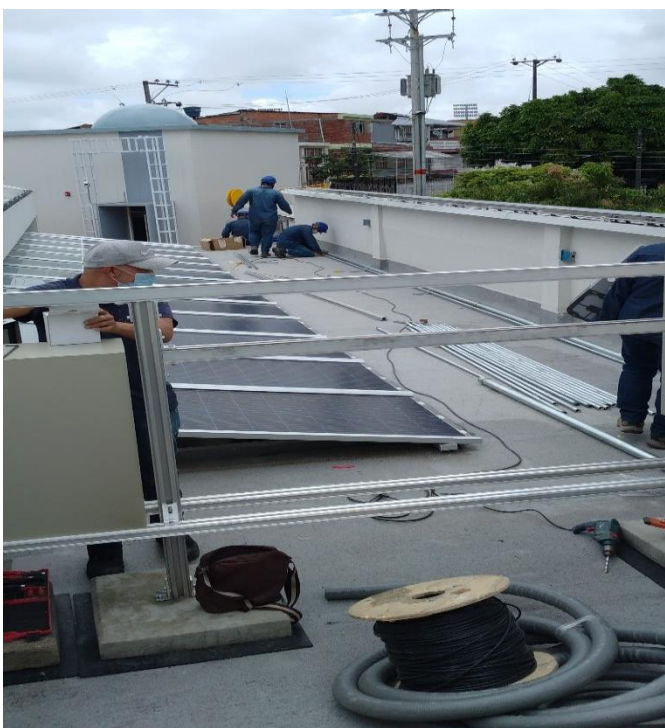
Ilustración 69 Labores de obra montaje de los gabinetes, ductos y conductores del sistema fotovoltaico.
