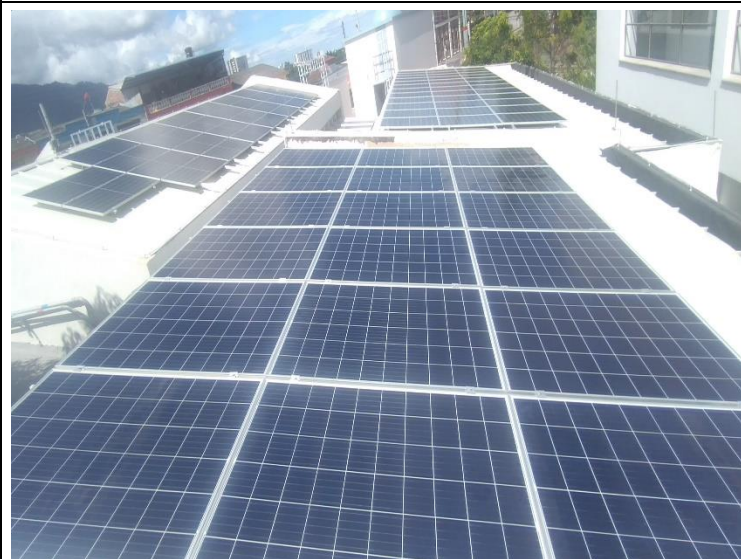
ilustración 19 áreas intervenidas donde se instalaron paneles solares.
