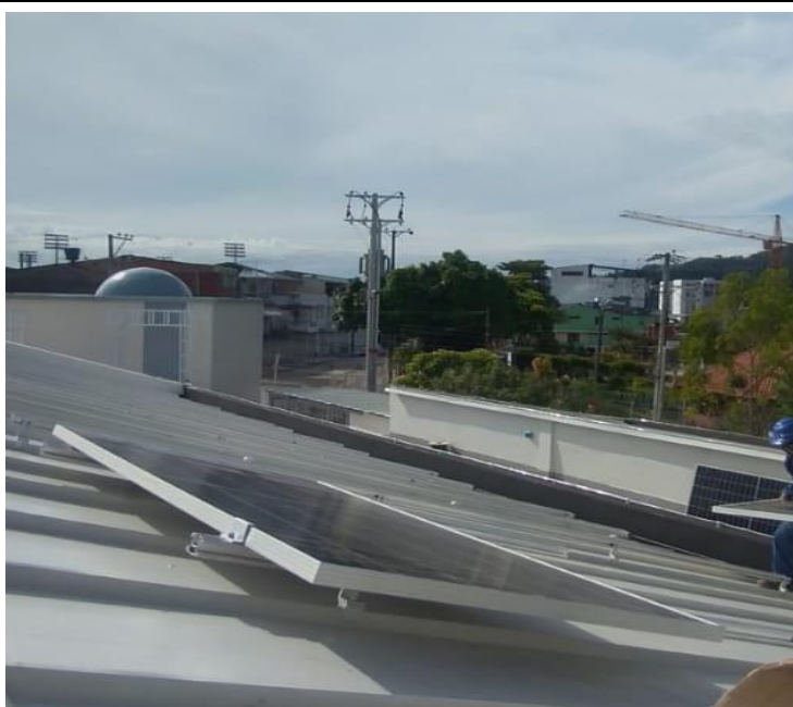
Ilustración 51 El primer panel instalado al iniciar labores.
