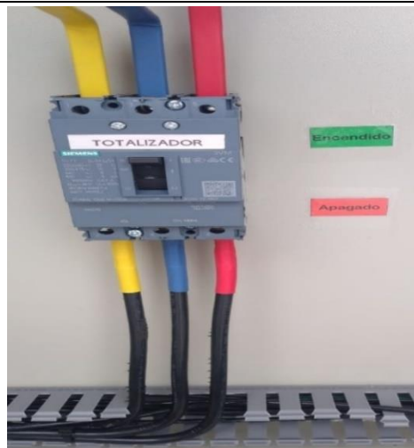
Ilustración 34 Totalizador fotovoltaico.
