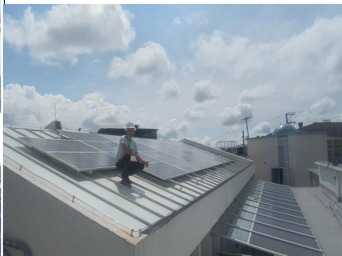
ilustración 20 instalación de estructura y fijación de paneles terminada.
