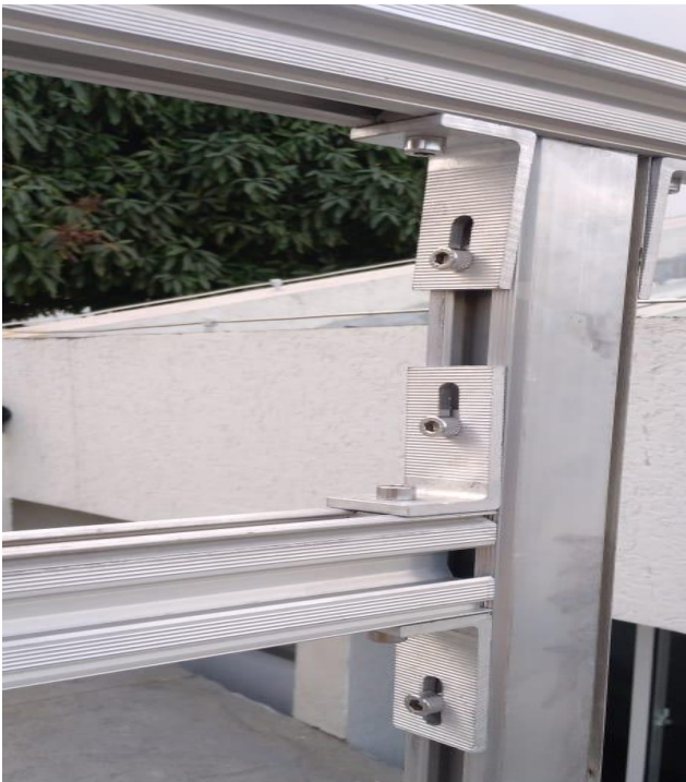
Ilustración 68 Estructura para fijar los gabinetes y equipos inversores.
