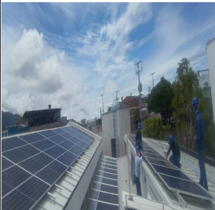
Ilustración 55 Labores de supervisión de obra con de la cuadrilla de trabajo.
