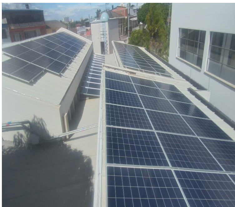
Ilustración 59 Envergadura de los paneles en las cubiertas intervenidas.
