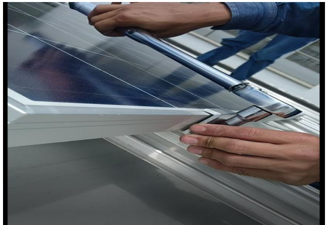
Ilustración 16 Fijando los paneles con una torquedadora, para evitar el exceso de fuerza y quebrar los paneles.
