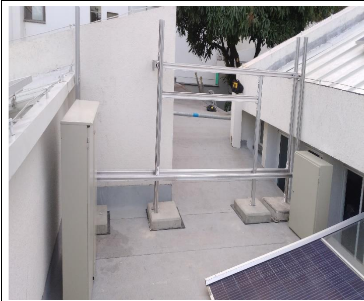
Ilustración 25 Estructura donde se van a fijar los gabinetes para las protecciones del sistema fotovoltaico.
