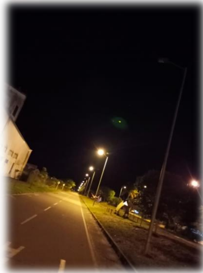
Ilustración 7. Fallas del sistema de AP
