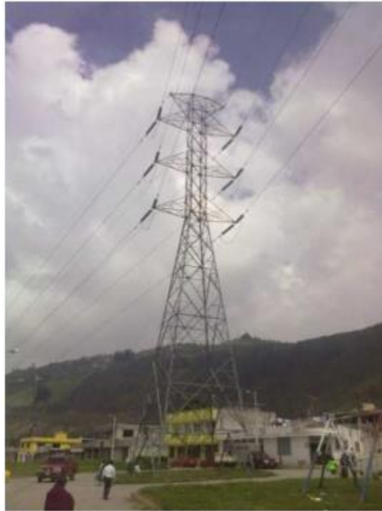
Ilustración 10. Torre de retención
