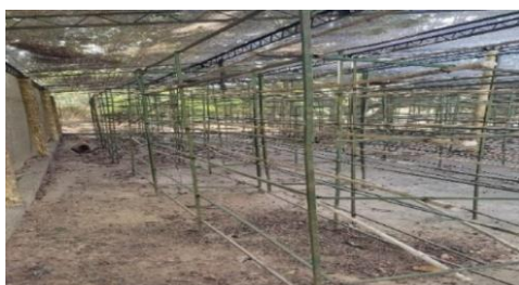
Imagen 3: Hidropónico en mal estado Vega (2023).
