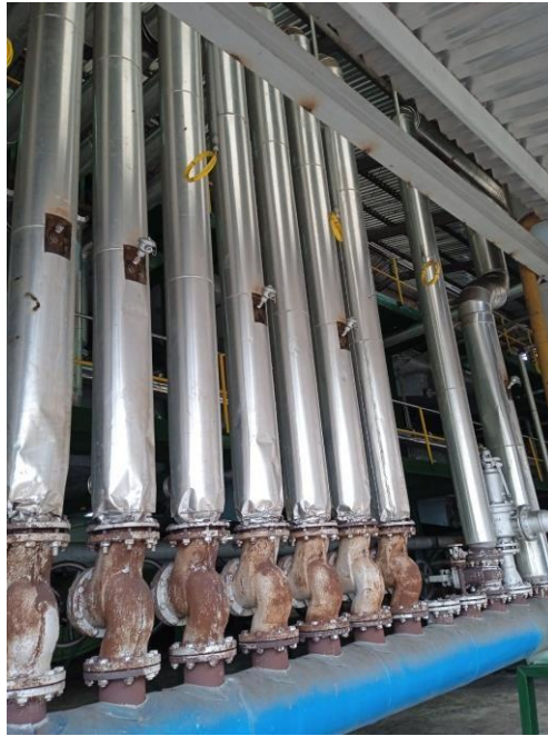
Figura 9. Termocuplas instaladas en el sitio de medición. Registro fotográfico.
