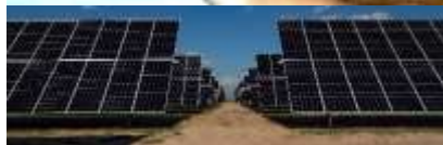
Inició la construcción del parque solar en, Fundación Magdalena
