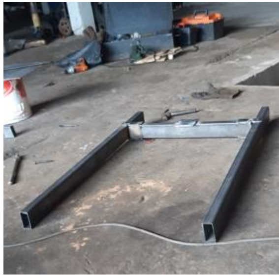
Figura 27. Soldadura de la base. (Autor)
