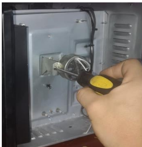
Figura 64. Instalación del sistema de rotación – motor síncrono Fuente: El Autor
