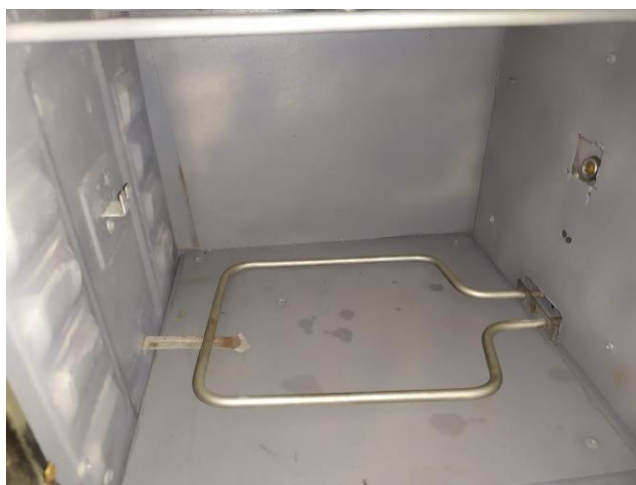
Figura 62. Instalación de sistema de calefacción
