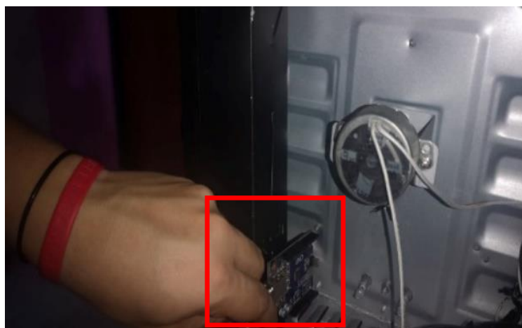
Figura 85. Instalación sistema de adquisición Fuente: El Autor
