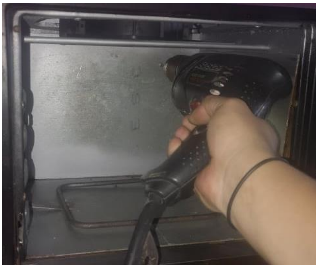
Figura 60. Instalación de láminas de acero inoxidable en la cámara de secado Fuente: El autor
