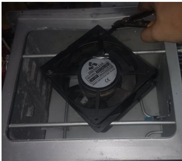
Figura 63. Instalación del sistema extractor de humedad Fuente: El Autor
