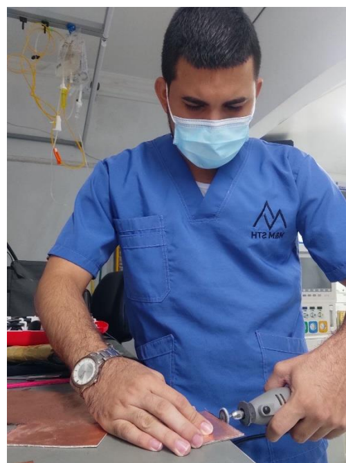
Ilustración 32 Proceso para cortar la baquela para montar el circuito de control automatizado para aires acondicionados
