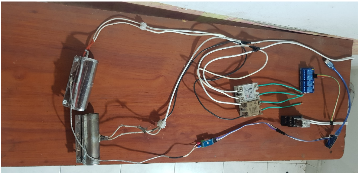
Figura 62. Circuito electrónico listo para conexiones. [Autor].
