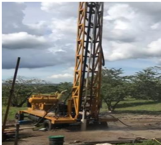
Figura 25. Limpieza y desarrollo del pozo profundo con compresor.
