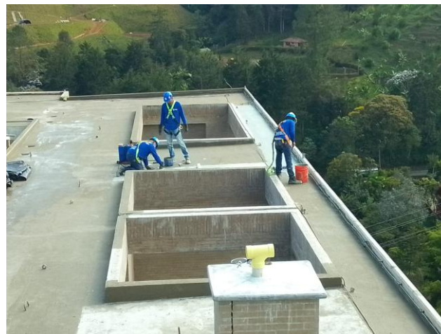
Finalizando impermeabilización de Torre 4.
