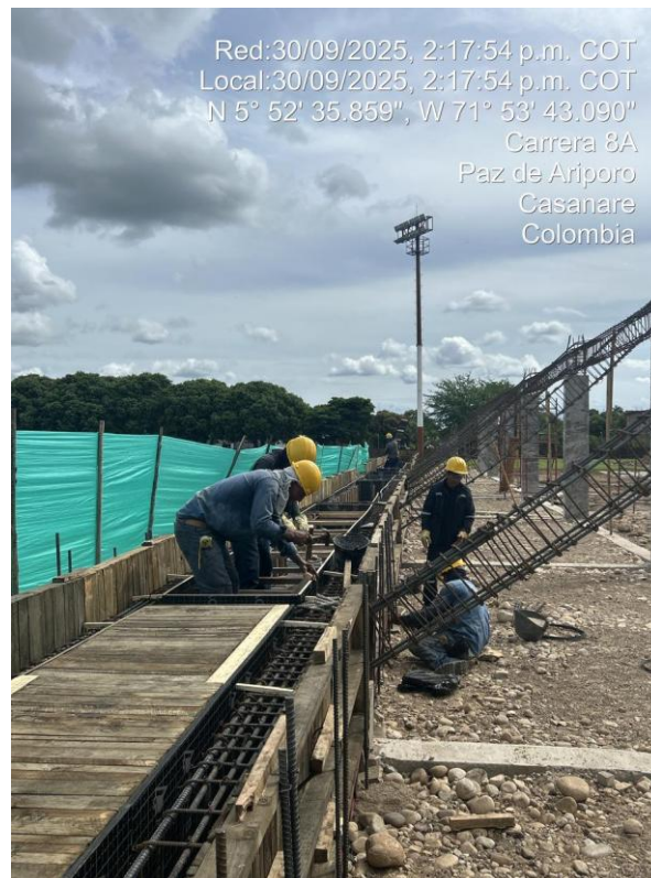
Figura 13: Armado de hierro y formaletado de graderías proyecto villa olímpica
