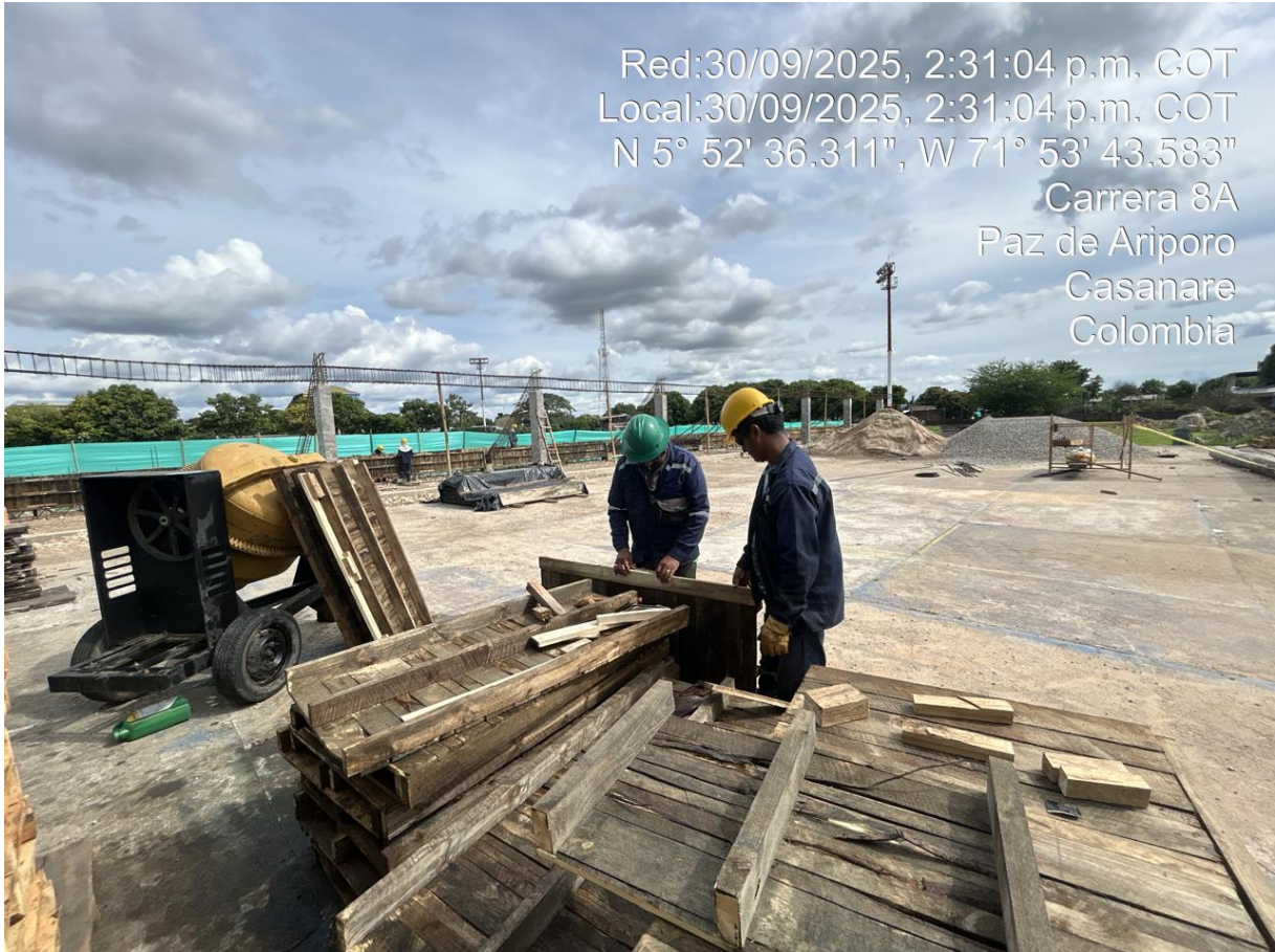
Figura 14: Revisión de calidad de materiales (formaletas en acero, estibas, tablas)
