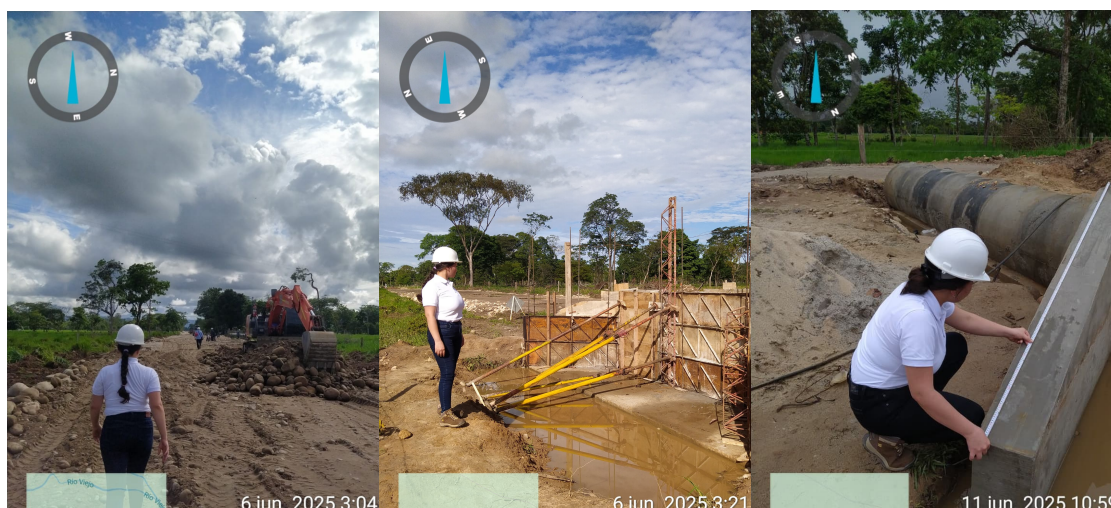
Figura 8 Inspecciones técnicas de campo
