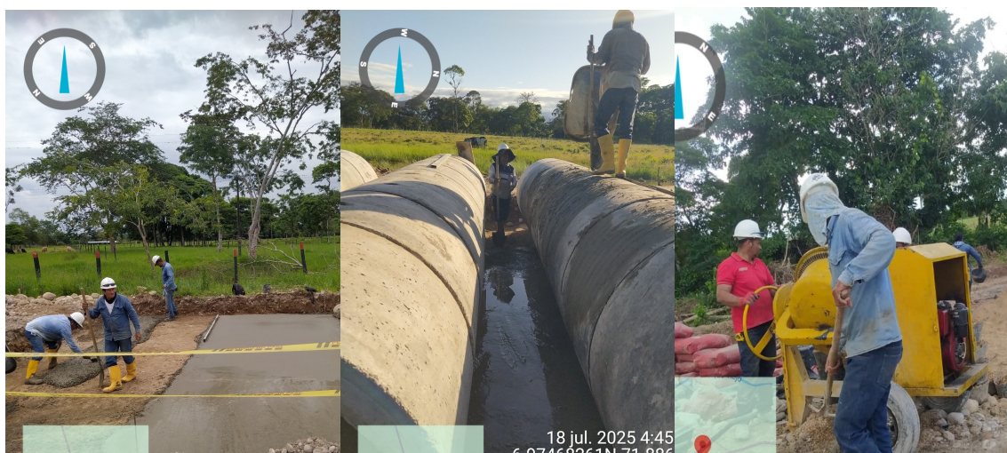
Figura 34 Evidencia fotográfica concreto resistencia 14 Mpa (F)
