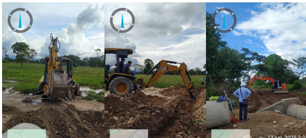
Figura 32 Evidencia fotográfica excavaciones mecánicas varias en material común seco
