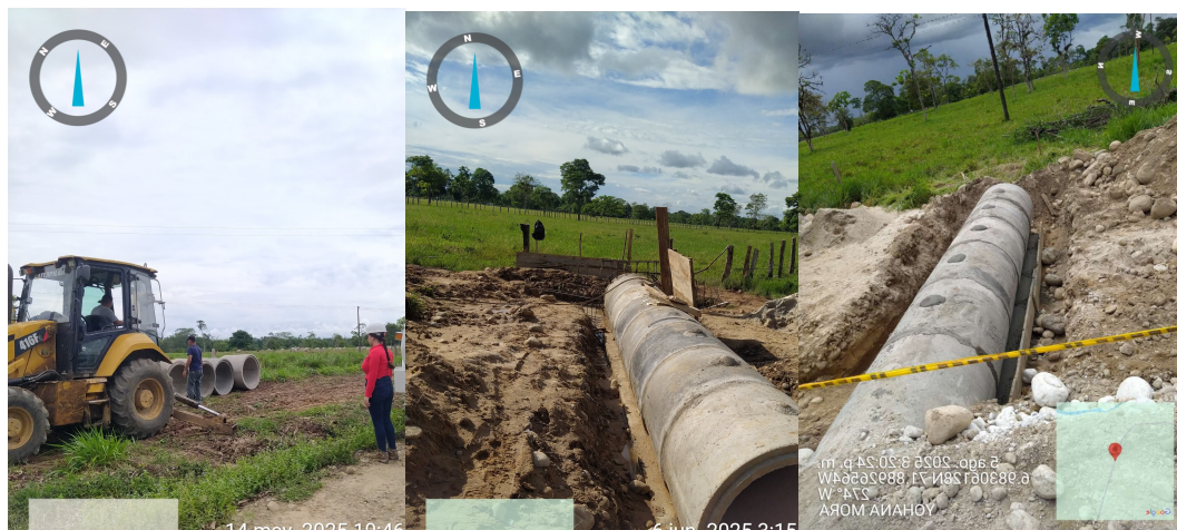
Figura 37 Tubería de concreto reforzado, clase II de 900 mm de diámetro interior
