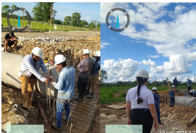
Figura 10 Verificación correcto uso de EPP
