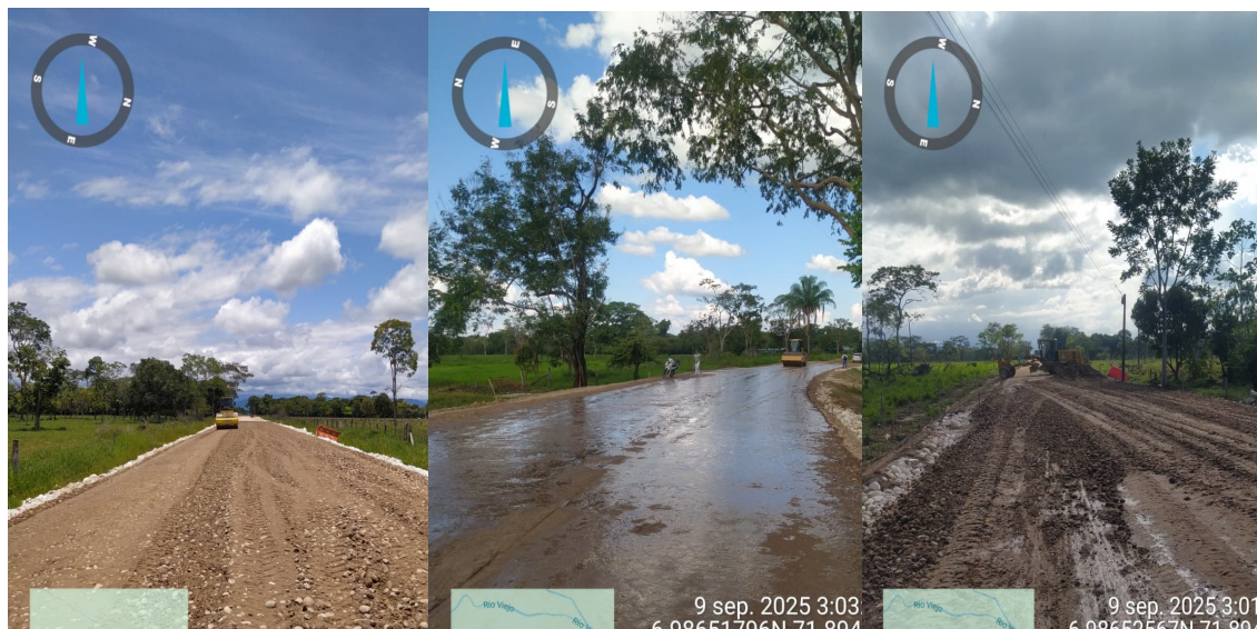
Figura 28 Evidencia fotográfica Subbase granular clase SBG-50
