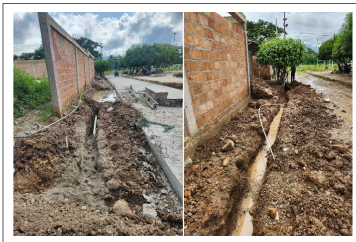
Figura 11. Suministro e instalación de tubería hidráulica en PVC 3"
