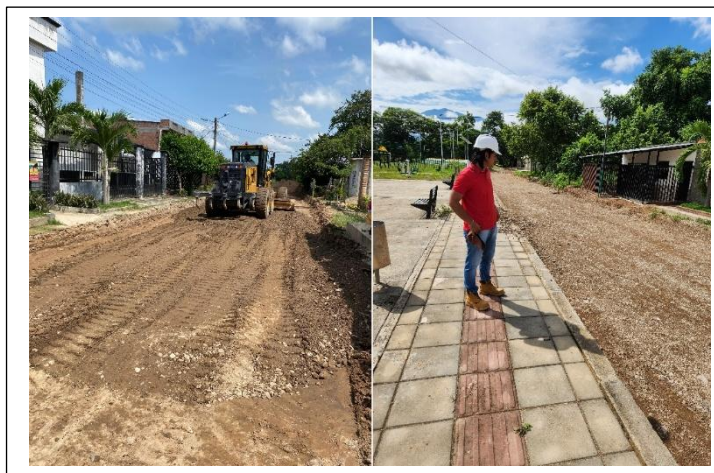
Figura 9. Suministro, extensión y compactación de la sub-base granular
