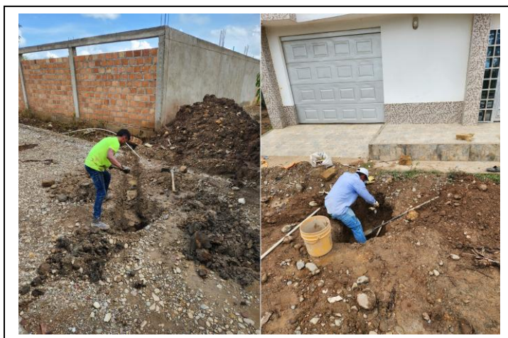
Figura 12. Excavación manual para acometida hidráulica
