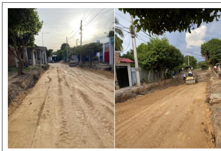
Figura 8. Relleno mecánico con material de terraplén
