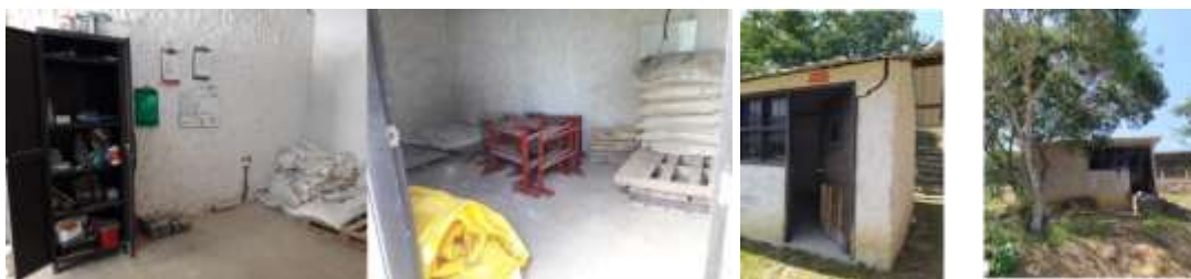
Figura 6. Estado interno y externo de las Bodegas Fuente: Avícola California. Autor: Niurka Alvarez
