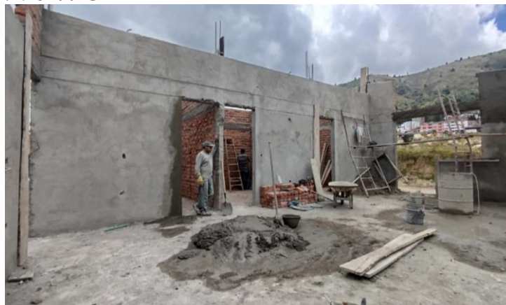
Figura 16 Proceso de pañetes vivienda C27
