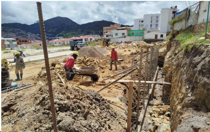
Figura 27. Proceso constructivo muro de contención
