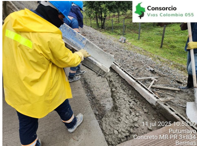
Figura 7. Fundida Bermas PR3+834.
