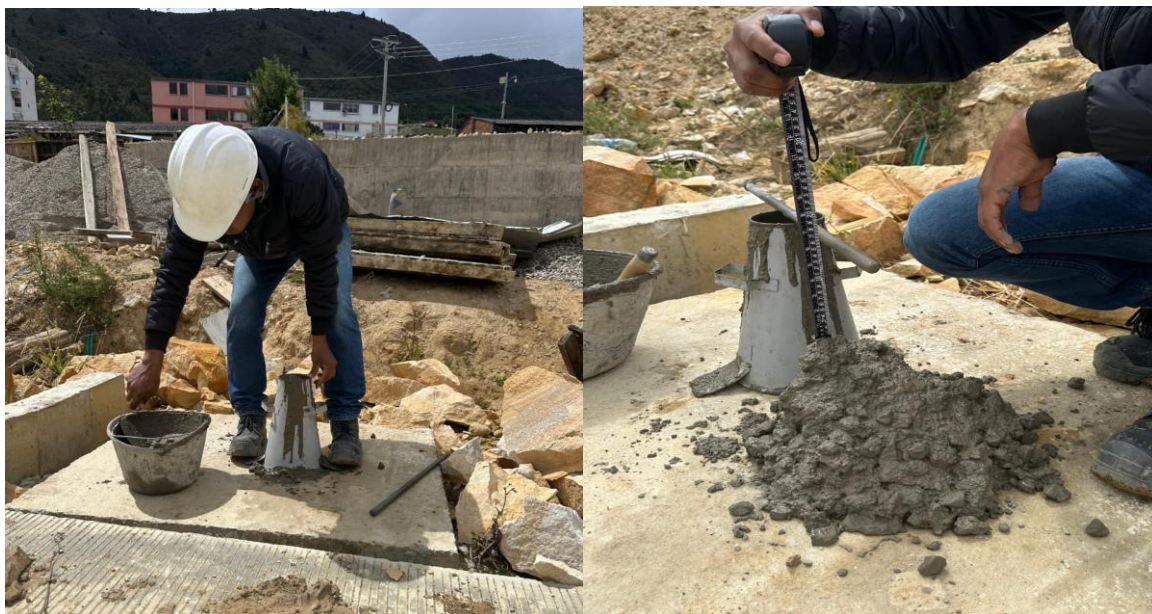
Figura 20. Ensayo de asentamiento del concreto
