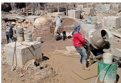
Foto n°4. Excavaciones de pedestales
