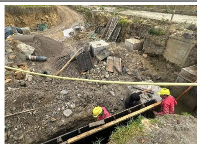
Foto n°3. Inicio de excavaciones
