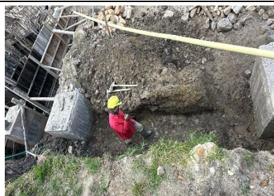
Foto n°1. Nivelación del terreno
