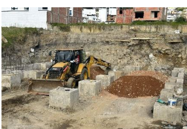
Foto n°8. Fundación de pedestales
