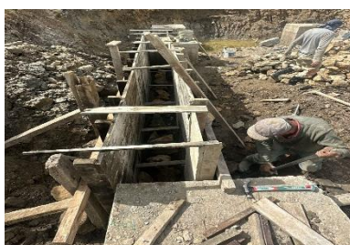
Foto n°5. Fundación de pedestales
