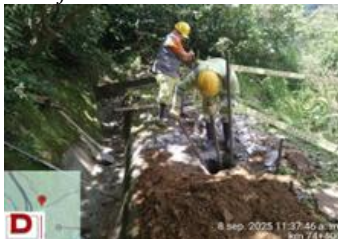
Figura 107. Instalación Puntos de Anclajes
