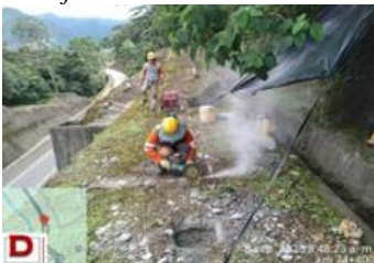
Figura 106. Instalación Puntos de Anclajes
