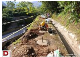
Figura 108. Instalación Puntos de Anclajes
