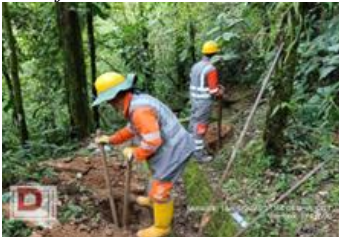
Figura 103. Instalación Puntos de Anclajes
