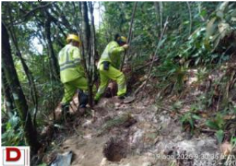
Figura 94. Instalación Puntos de Anclajes
