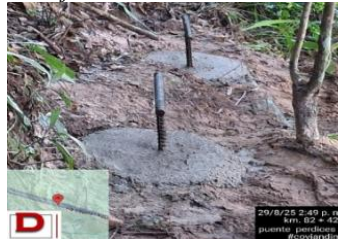
Figura 96. Instalación Puntos de Anclajes
