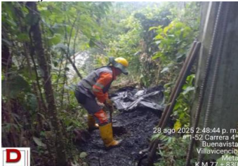
Figura 100. Instalación Puntos de Anclajes
