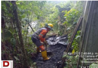
Figura 101. Instalación Puntos de Anclajes
