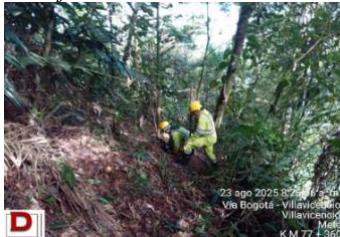
Figura 98. Instalación Puntos de Anclajes
