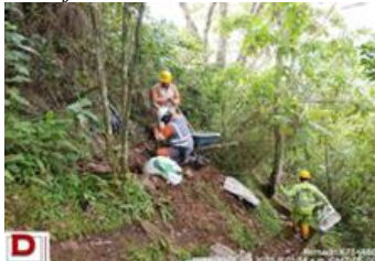
Figura 104. Instalación Puntos de Anclajes
