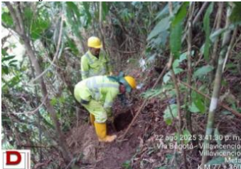
Figura 97. Instalación Puntos de Anclajes
