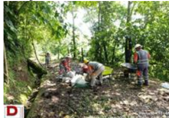
Figura 105. Instalación Puntos de Anclajes
