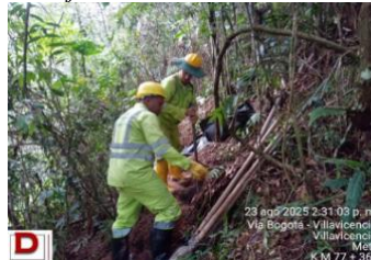
Figura 99. Instalación Puntos de Anclajes
