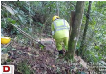
Figura 95. Instalación Puntos de Anclajes
