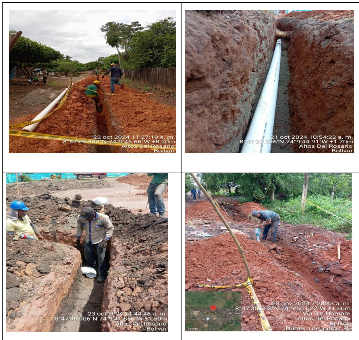
Figura 25: Supervisión de obra
