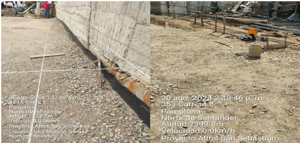
Ilustración 40 Preparación del terreno y trazado de hilos mediante ejes
