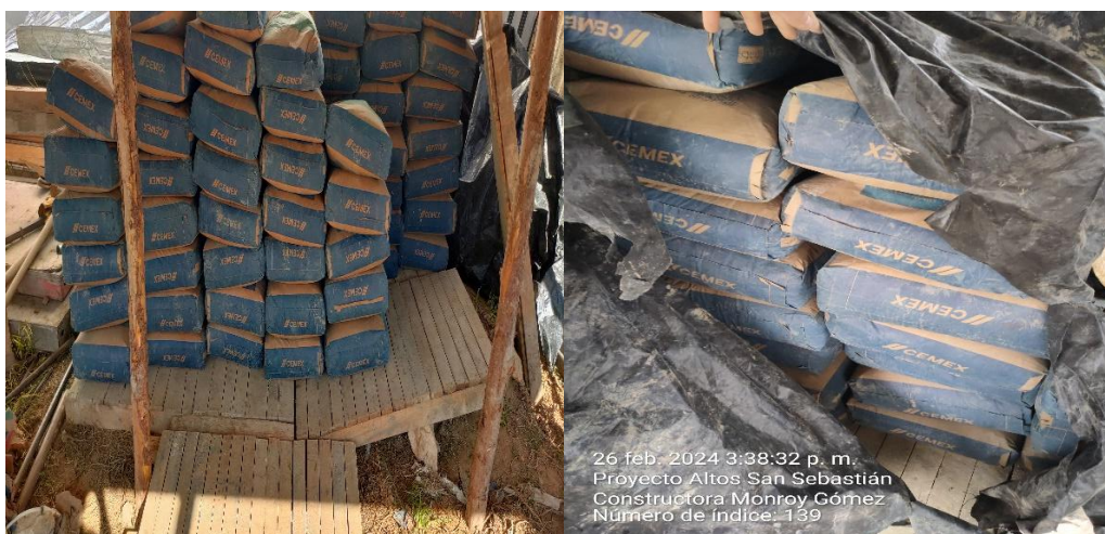
Almacenamiento del cemento
